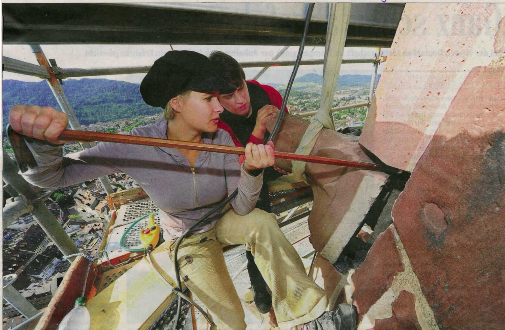
Jenny Steiger und Florian Pruszeit bearbeiten mit Geduld und Brecheisen die Kupferklammer.
