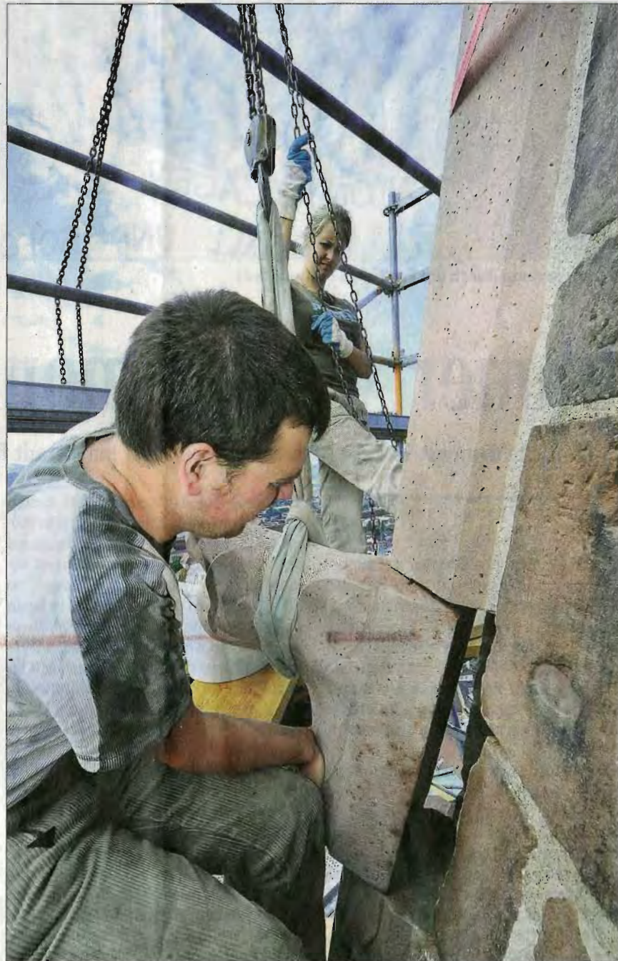
Mit Kettenzug und mit vereinten Kräften beim Steineinbau: Markus Himmelsbach und Jenny Steiger.
