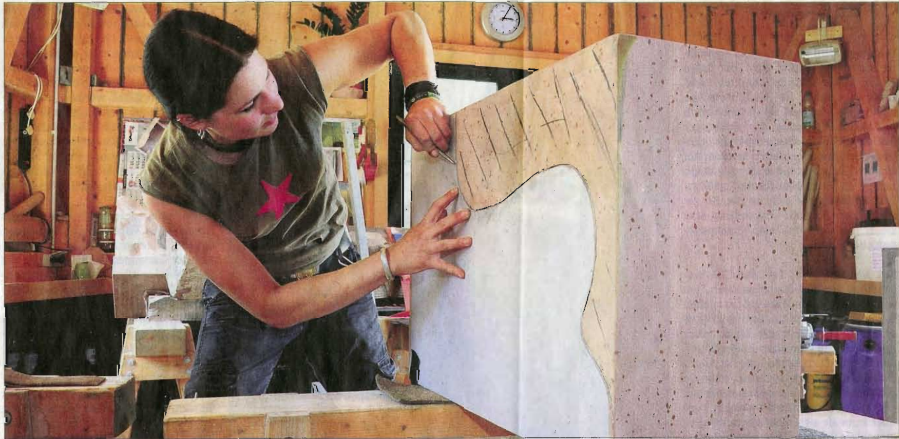
Steinmetzin Florentine Sommer zeichnet seitlich am neuen Steinquader den Verlauf des Grates auf, an dem sie sich dann orientiert.
