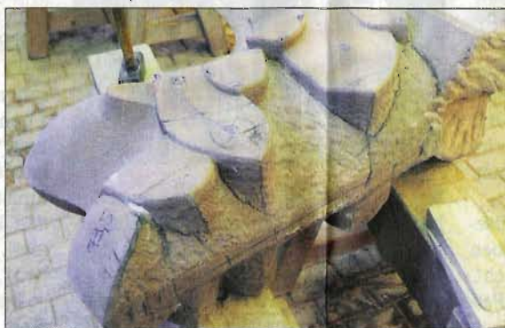
Zuerst werden die Orientierungspunkte auf der Originalkrabbe markiert und später dann auf den neuen Stein übertragen.
