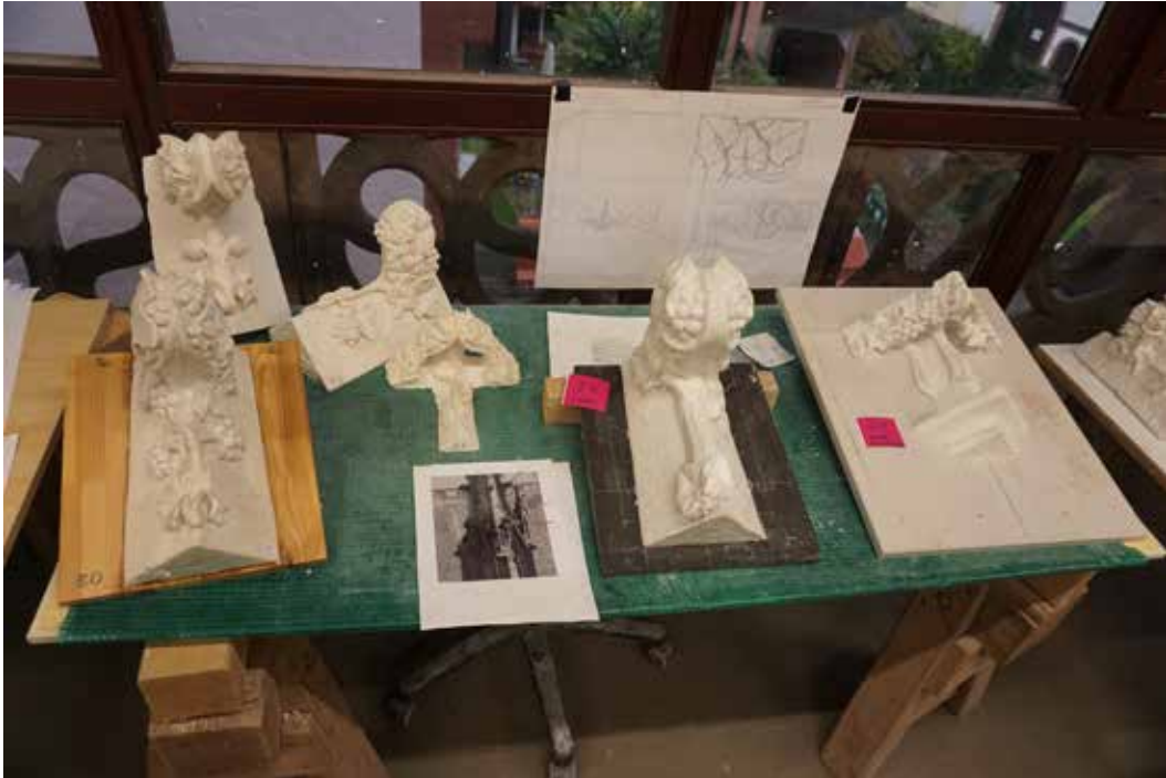
Abb. 54 Mehrere Arbeitsschritte sind notwendig, um die Formen in ihrer Dimension und Gestalt der Geometrie des Pfeilers und auch dem Formenschmuck der angrenzenden Bauteile anzupassen. Foto 16.09.2022.
