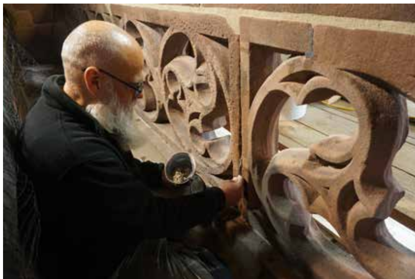
Steinmetz Johannes Walz bei der Konservierung der Maßwerkbrüstung im Joch 1.
