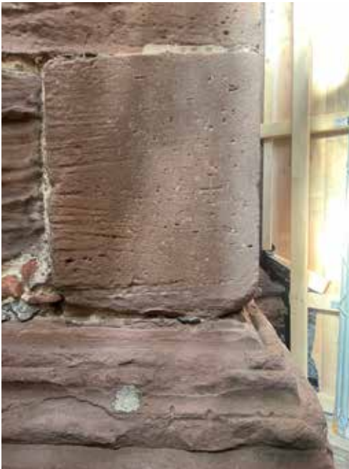
Abb. 8 Detail eines Pfeilersteines mit Sockel im Vorzustand. Foto 17.10.2022.
