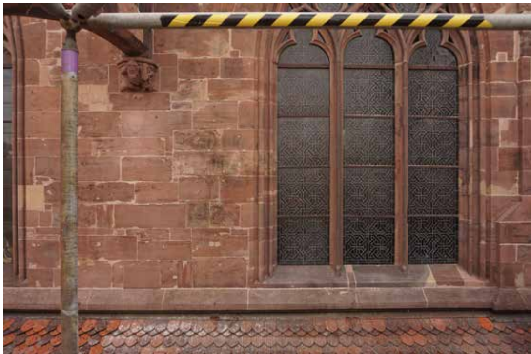
Abb. 75 Östliche Wandfläche und Maßwerkfenster mit wiederhergestellter Fensterbank. Foto 07.09.2022.
