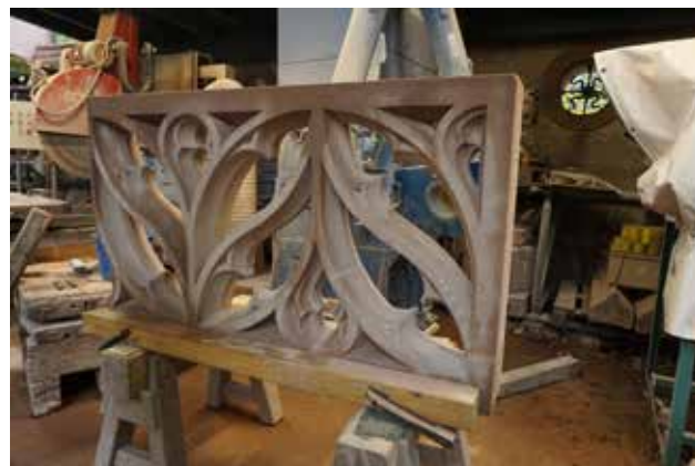
Abb. 22 Das neu geschlagene Maßwerk vom Steinmetz Nikolai Pajevic. Foto 16.05.2023.
