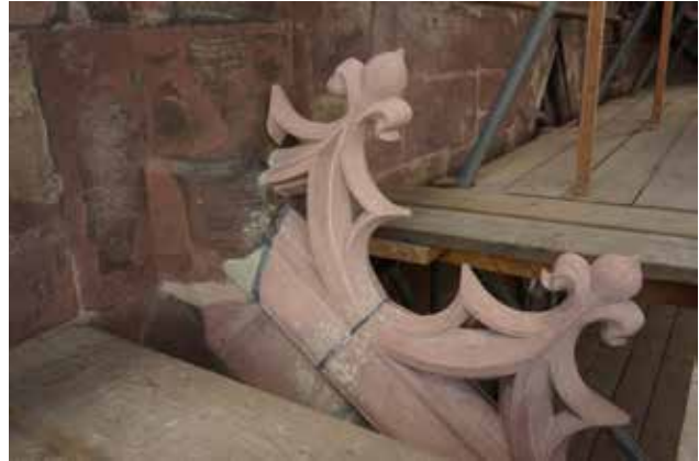
Abb. 89 Nach Abschluss der Maßnahmen an der Fensterbank. Foto 24.05.2022.
