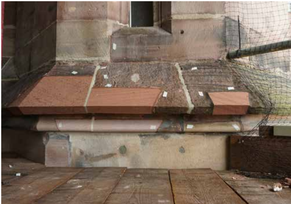
Abb. 68 Die zerstörte Profilkante am angrenzenden Treppenturm wird mit steinernen Passstücken wieder ergänzt. Foto 09.06.2022.
