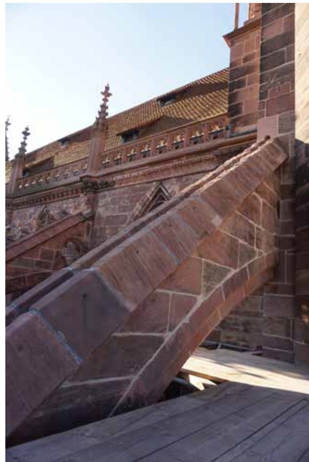
Abb. 82 Der Strebebogen 0/1 nach dem Ausrüsten. Foto 26.08.2022.
