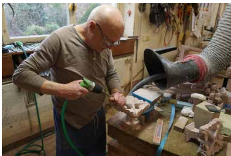
Abb. 44 Eine der kleinen Kreuzblumen (Pos. 4.2h) während der Fertigung durch den Steinbildhauer Andreas Steffan. Foto 03.02.2022.
