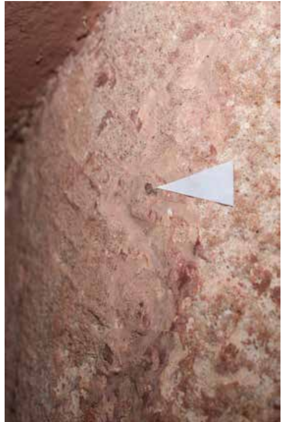
Abb. 65 Wandflächen unter der Renaissancevorhalle. Fragmente eines sehr kräftigen Grüns in Befund 013. Foto 21.11.2022.
