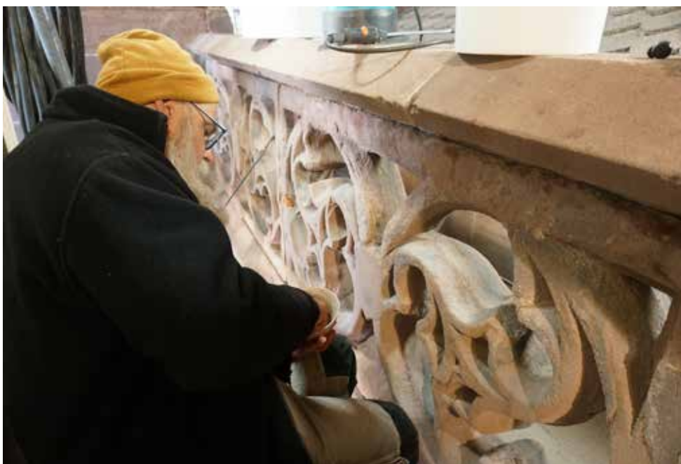
Abb. 69 Johannes Walz bei der Konservierung der Maßwerkbrüstung im Joch 1. Foto 11.04.2022.
