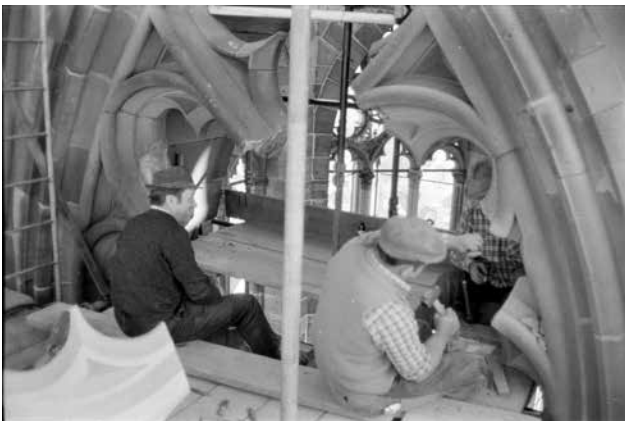
Abb. 114 Arbeiten am Fenstermaßwerk des Oktogons. Foto aus den 1960er Jahren (MBV Archiv).
