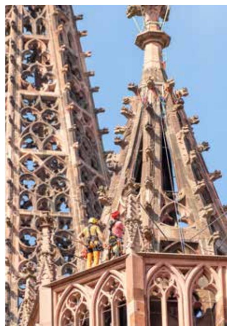
Abb. 130 Monitoring am südlichen Hahenturm. Foto 12.09.2022.
