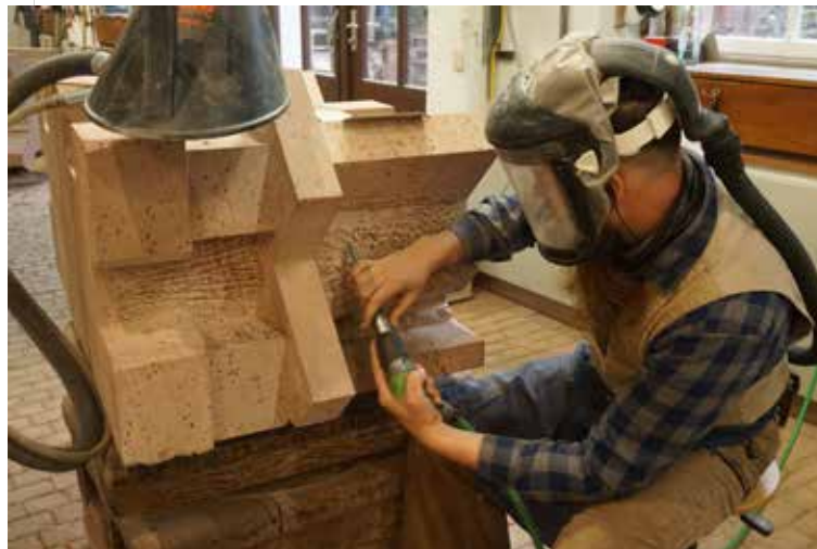
Abb. 49 Der Steinmetz Markus Himmelsbach arbeitet die Flächen und Profile des Bauteils (Pos. 5.1b) mit Drucklufthämmern und Meißeln weiter aus. Foto 20.12.2022.
