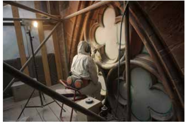
Abb. 83 Untersuchung der Maßwerkoberflächen auf Farbfassungen durch Andrea Zurl. Foto 26.01.2022.
