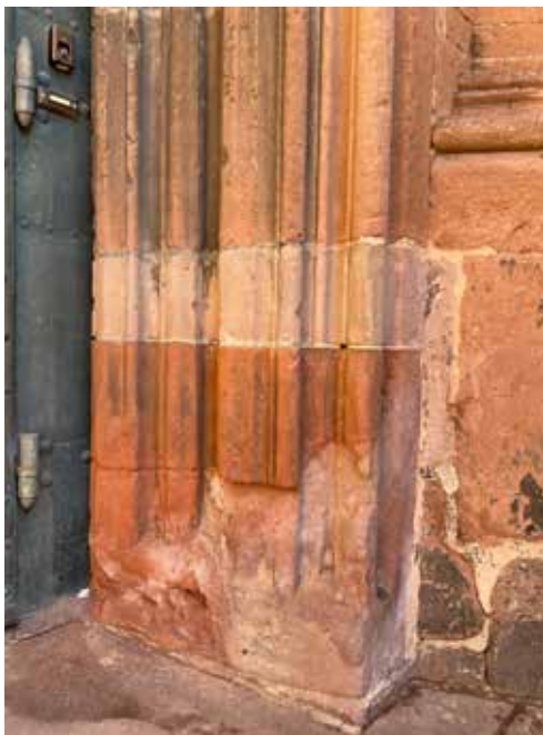
Abb. 5 Rechtes Gewände des Marienportals im Vorzustand. Foto 15.05.2022.
