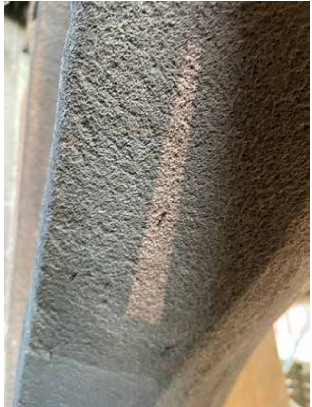
Abb. 24 Der helle Bereich zeigt ein Reinigungsmuster. Foto 11.10.2022.
