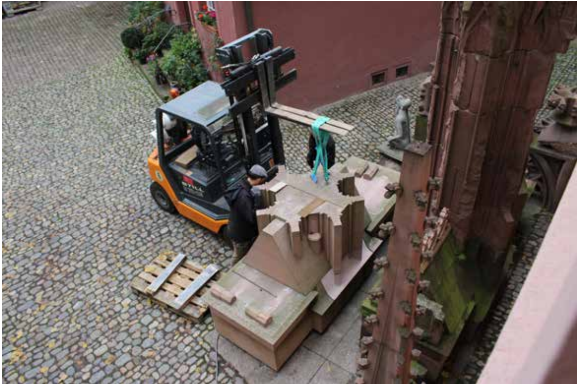
Abb. 59, 60 Probeaufbau der unteren Steinlagen und Vorbereiten der Aufhängungsvorrichtungen im Stein. Fotos 01.12.2022.
