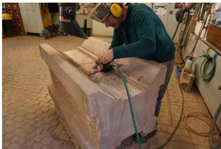
Abb. 50 Der Fialenschäft des mittleren quadratischen Bereiches wird von dem Steinmetzen Bertram Fliegau gefertigt. Foto 06.12.2022.
