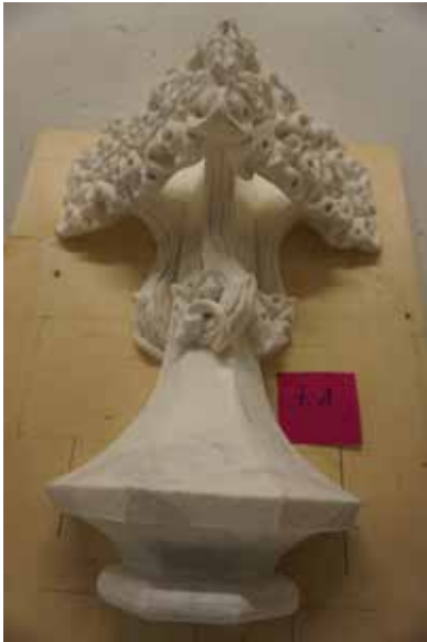
Links: Abb. 56 Ein Entwurfsmodell für eine Wimpergkreuzblume (Pos. 7.1) von schräg unten betrachtet. Die rechte und linke Flügelseiten sind als Varianten im Detail etwas unterschiedlich angelegt. Foto 16.09.2022.
