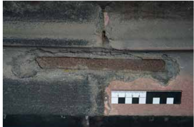
Abb. 104 Eisenklammern im Bleibett aus dem 19. Jahrhundert. Foto 26.07.2022.
