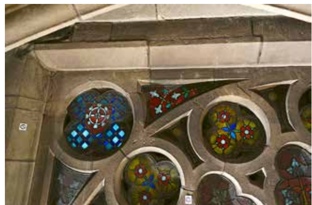
Abb. 112 Steinaustausch an der oberen rechten Ecke von Innen. Foto 21.07.2022.
