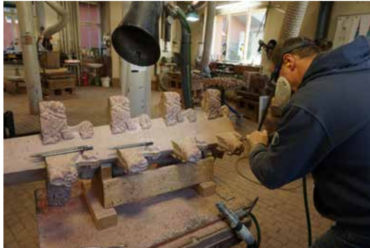
Abb. 32 Die zweite Fiale (Pos. 3.2b) in Arbeit durch den Steinmetzen Michael Kästner. Foto 01.03.2022.
