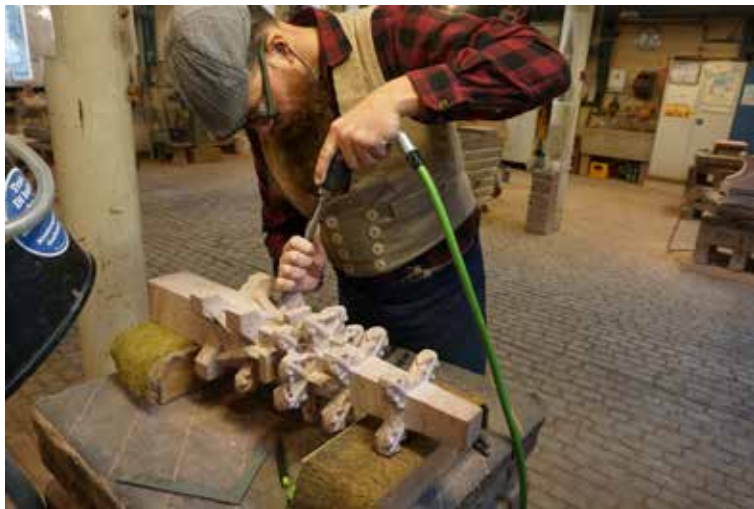
Abb. 40 Eine kleine Fiale für den mittleren polygonalen Fialenbereich (Pos. 4.1c) während der Fertigung durch den Steinmetzen Markus Himmelsbach. Foto 13.01.2022.
