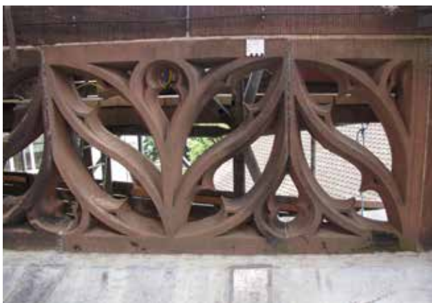
Abb. 19 Das Maßwerk bevor es ausgebaut wurde. Foto 28.06.2022.
