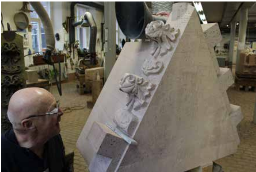
Abb. 28 Die Vorderseite der Pfeileraufsatzbedachung mit der Giebelfläche (Pos.1.2a). Im Hintergrund die noch vorhandene Rückseite mit den Krabben-vorlagen. Foto 15.12.2022.
