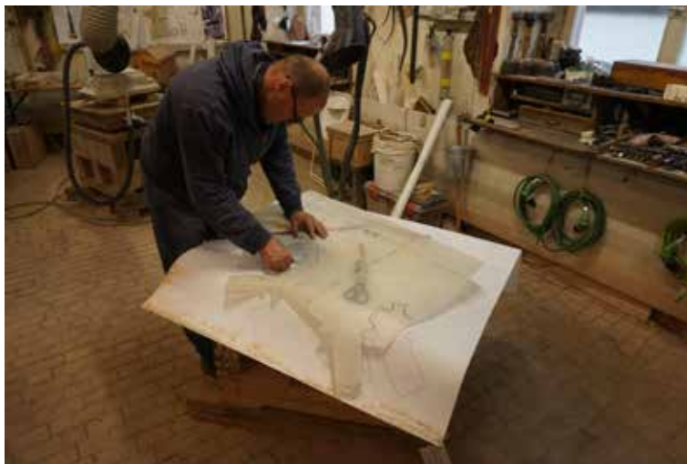
Abb. 35 Das Modell des Blattkapitells (Pos. 3.5a) wird vom Steinmetzen Michael Kästner in die bereits gefertigten Steinschichten mit Hilfe der dazugehörigen Schablonen eingepasst. Foto 05.05.2022.
