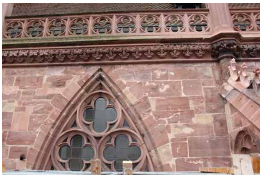
Abb. 88 Der Ober­gadenbereich nach der Sanierung. Foto 18.08.2022.
