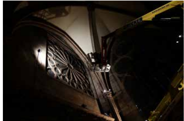
Abb. 109 Hubsteigerbefahrung im Münsterinnenraum zur Vermessung der nördlichen Fensterrose. Foto 21.07.2022.
