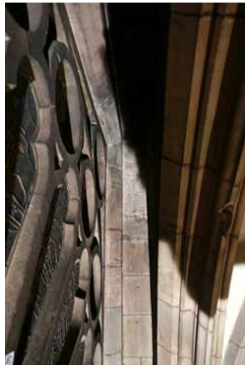
Abb. 111 Gewölbeüberschneidung an der oberen rechten Ecke der Fensterrose. Foto 21.07.2022.
