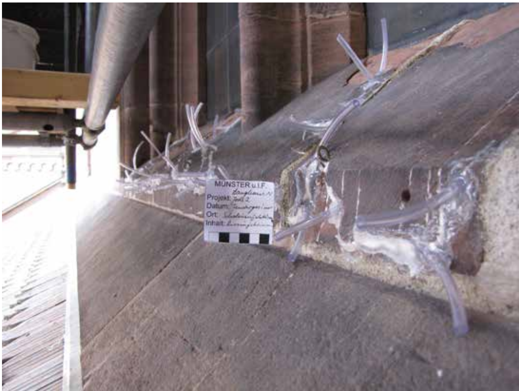
Abb. 84 Die Obergadenfensterbank während der Rissverfüllungsmaßnahmen. Foto 04.05.2022.
