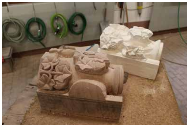
Abb. 39 Das zweite Blattkapitell (Pos. 3.5b) kurz vor der Vollendung neben dem Gipsmodell. Foto 29.09.2022.
