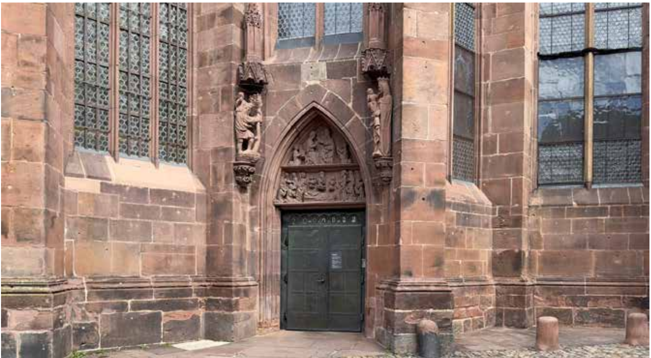
Abb. 2 Der steinkonservatorisch behandelte Arbeitsbereich der Joche 9-11 im Endzustand. Foto 05.07.2022.
