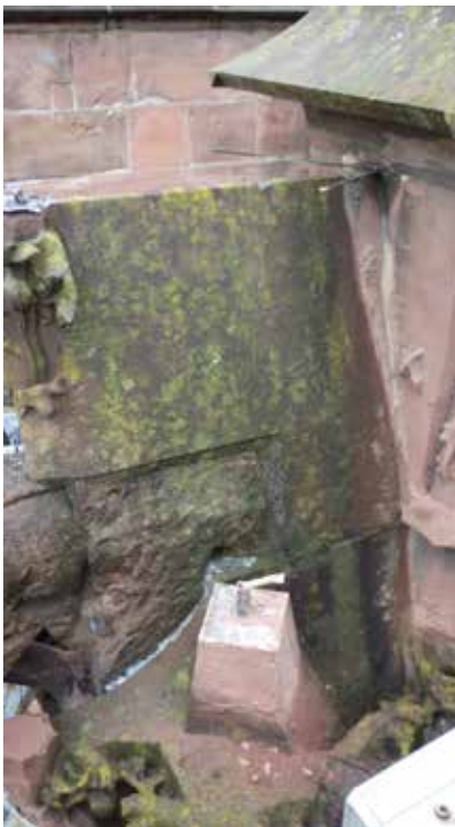
Abb. 132 Nach Abnahme der Fiale von Abb. 127. Foto 28.09.2022.
