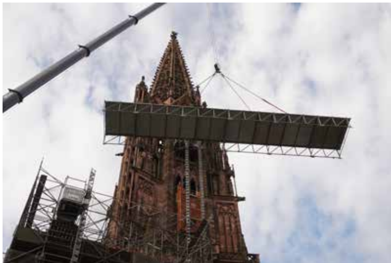
Abb. 92 Mit Hilfe eines Autokrans wurde ein Teil der Dachkonstruktion auf den Münsterplatz herabgelassen. Foto 31.05.2022.
