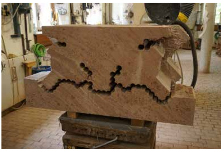
Abb. 47 Das Gegenstück zu Pos. 5.1a. (Pos. 5.1b). Mit einem Diamant-Nasshohlbohrer werden die äußeren Konturen freigelegt. Foto 04.07.2022.
