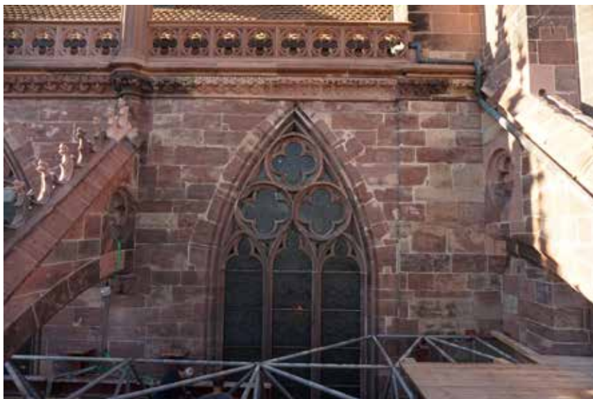
Abb. 73 Der Brüstungs- und obere Fensterbereich vom Obergaden. Foto 25.08.2022.
