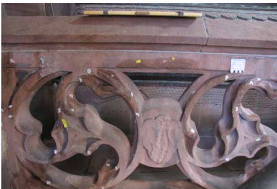
Abb. 71 Die Antraguungen werden nachgefestigt und abschließend dokumentiert. Foto 25.05.2022.
