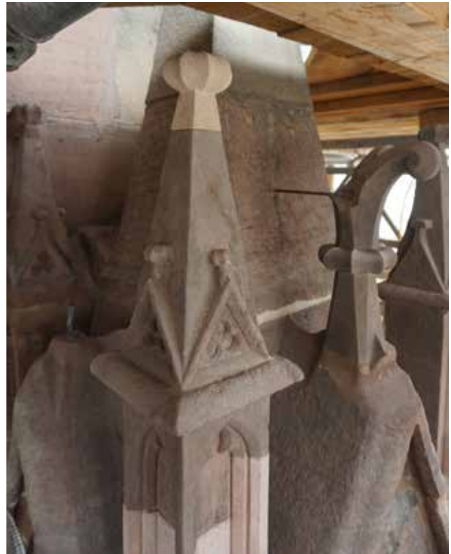
Abb. 76 Die Fialenbekrönung des Figurentabernakels vom Pfeiler 0/1 nach der Sanierung. Foto 26.01.2022.
