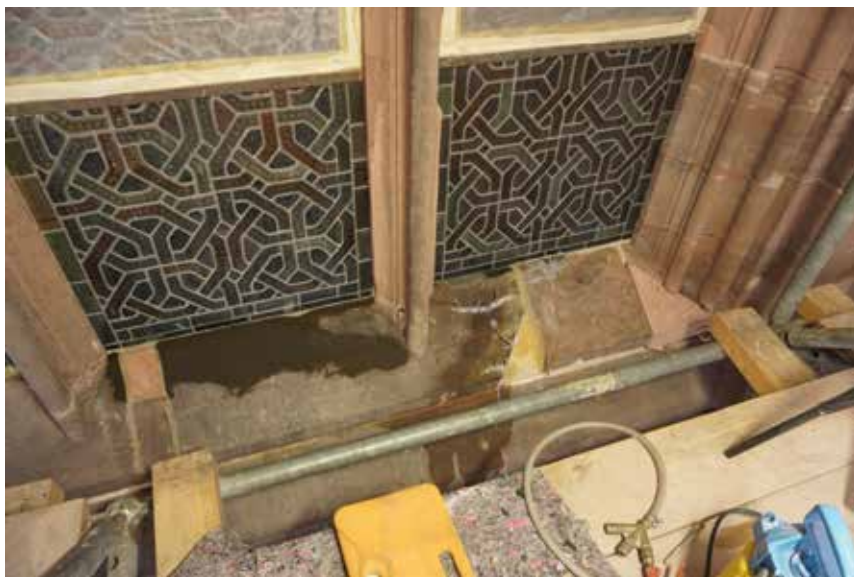
Abb. 72 Mit kleineren Vierungs und Mörtelergänzungen wird die Fensterbank wieder konsolidiert. Foto 16.03.2022.
