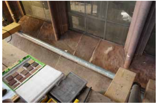
Abb. 86 Nach Abschluss der Maßnahmen an der Fensterbank. Foto 24.05.2022.
