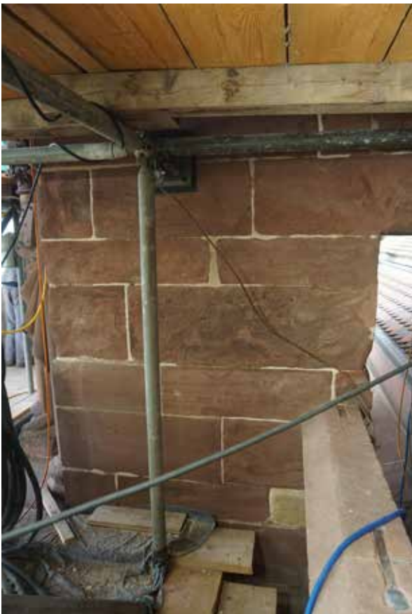
Abb. 88 Konservierungsarbeiten am Pfeilerdurchgang. Foto 11.10.2022.
