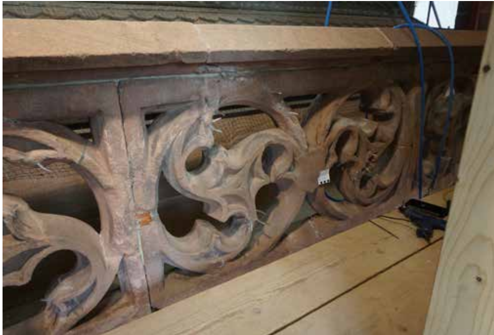
Abb. 70 Rissverfüllung mit Mikrozementmischung. Foto 26.04.2022.
