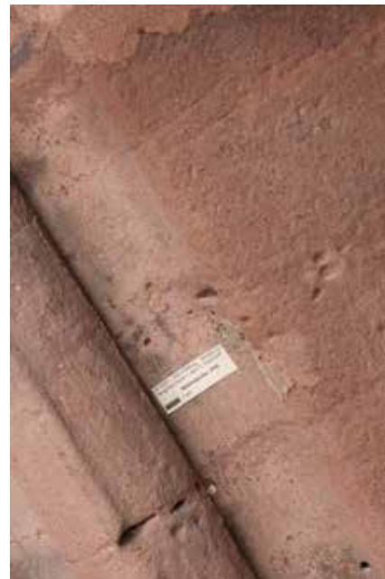
Abb. 121 Gewändeprofil des Hochschiffensters; in der Hohlkehle liegen Reste eines hellen rosafarbenen Anstrichs, der dem roten Sandstein sehr ähnelt. Foto 18.03.2022.
