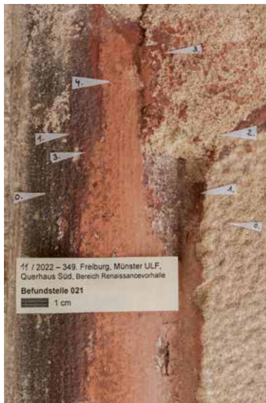
Abb. 66 Wandflächen unter der Renaissancevorhalle. Befund 021. Foto 21.11.2022.
