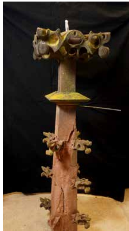
Abb. 133 Die geborgene Fiale wurde in der Restaurierungswerkstatt notgesichert und im Lapidarium eingelagert. Sie kann später als Vorbild für eine Kopie genutzt werden. Foto 16.02.2022.
