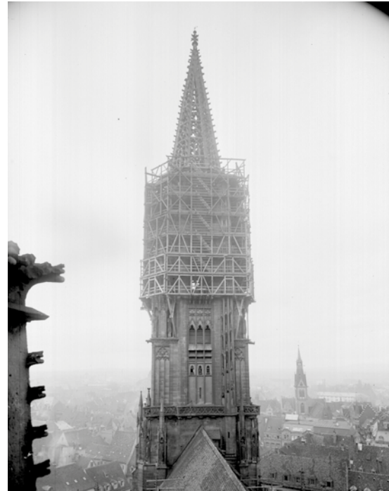
Abb. 113 Im frühen 20. Jahrhundert wurde das Turmoktogonal mit einem aufwändigen Holzgerüst versehen. Foto aus dem Jahr 1913 (MBV Archiv).
