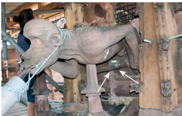
Abb. 127 Am Unterbein des Wasserspeiers am Aufsatz des Strebepfeilers 14/15 liegen evt. Fassungsreste. Foto 11.07.2022.
