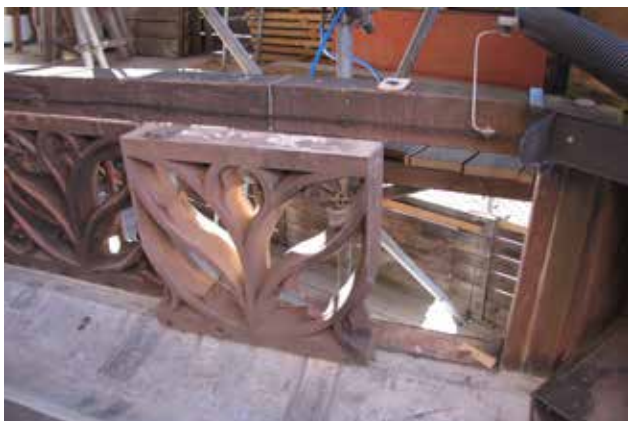
Abb. 21 Ausgebautes Maßwerkteil. Foto 11.07.2022.
