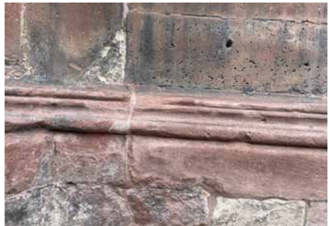
Abb. 11 Detail vom Sockel mit seinem Profil im Endzustand. Foto 16.02.2022.
