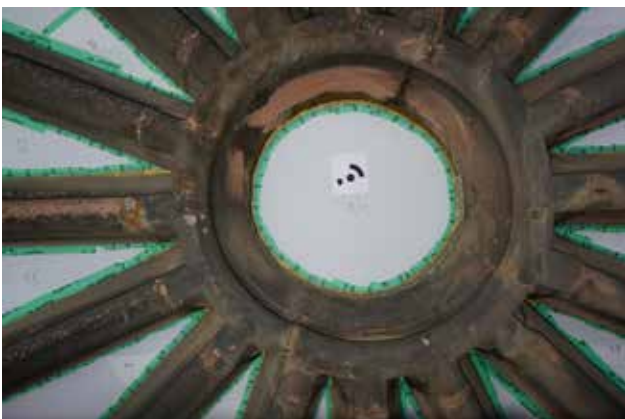
Abb. 106 Okulus des Rosenfensters mit Abarbeitungsspuren. Foto 26.07.2022.
