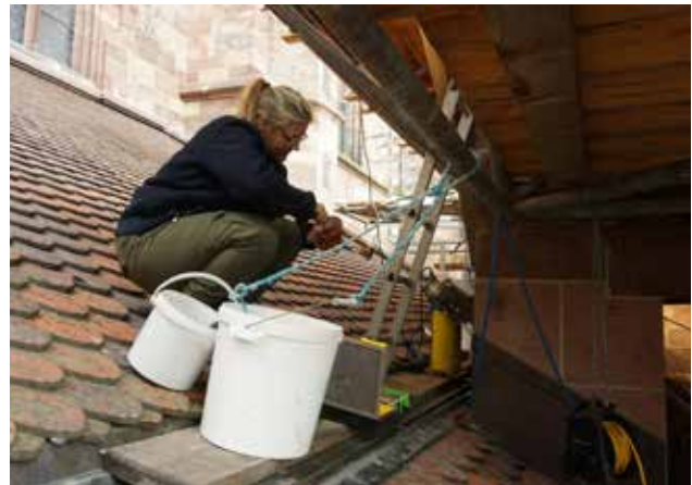
Abb. 87 Senta Eberhardt bei Konservierungsarbeiten an den Anschlussflächen zum Dach. Foto 11.10.2022.
