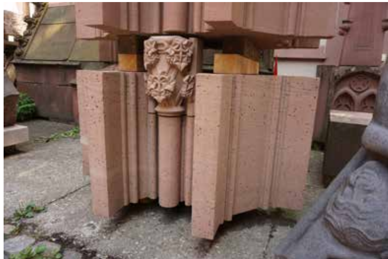
Abb. 38 Das Blattkapitell (Pos. 3.5a) beim Probeaufbau an der künftigen Position. Hier gut zu erkennen die Riegelverbindung zwischen den beiden Steinschichten. Foto 04.07.2022.
