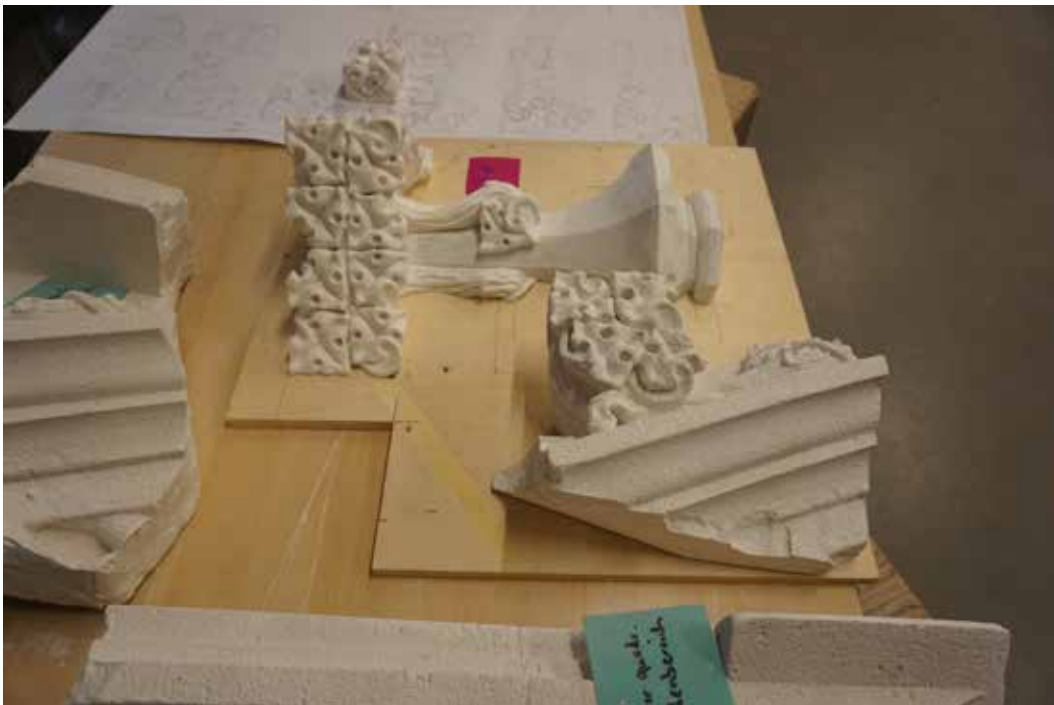
Abb. 55 Vorne das vervollständigte Fragment einer Wimbergkrabbe für den oberen quadratischen Fialenbereich. Im Hintergrund ein Entwurf für die dazugehörige Kreuzblume (Pos. 7.1). Foto 16.09.2022.
