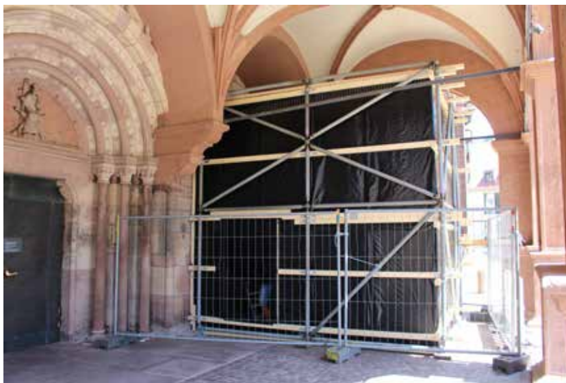
Abb. 61 Unter der Renaissancevorhalle, vor der südöstlichen Querhauswand wurde zur Farbbefundung ein lichtdichter Kasten aufgebaut. Foto 18.07.2022.
