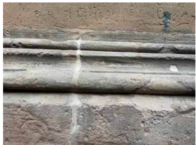
Abb. 4 Detailaufnahme vom Endzustand des Sockelprofils mit einer neuen Antragung am Joch 10. Foto 18.07.2022.
