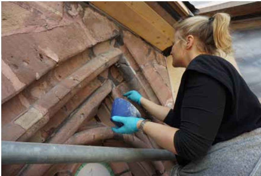
Abb. 87 Reparaturen im Spitzbogen. Foto 11.04.2022.
