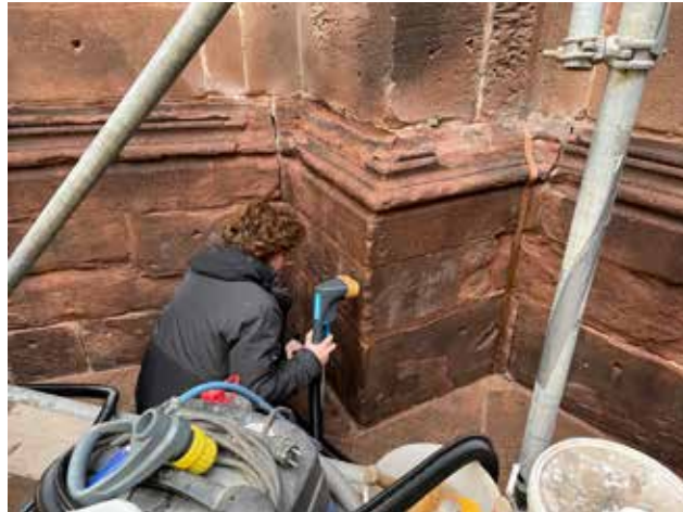
Abb. 7 Restauratorin Leonie Gockel beim Arbeiten mit dem Gregomat für die Salzminderung. Foto 16.02.2022.
