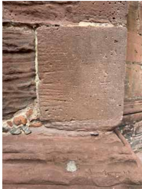
Abb. 9 Detail eines Pfeilersteines mit Sockel im Endzustand. Foto 16.02.2023.
