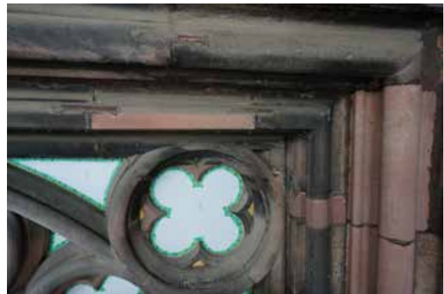
Abb. 97 Rosenfenster, obere rechte Ecke mit Kunststoffschablonen zum Schutz des Fensterglases. Foto 26.07.2022.
