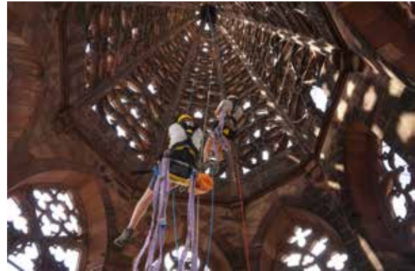
Abb. 129 Monitoring im Turmhelm. Foto 20.06.2022.
