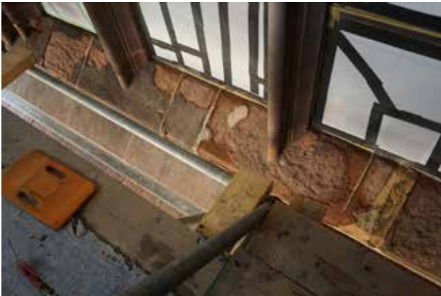
Abb. 85 Schrittweises Antragen von Steiner­gänzungsmassen. Foto 11.04.2022.
