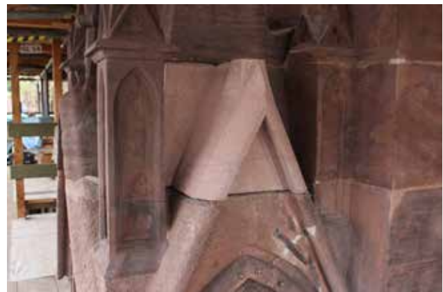
Abb. 78 Neu geschaffene Giebelspitze des Strebepfeilers 0/0. Foto 26.10.2022.
