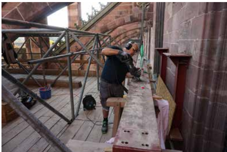
Abb. 93 Ein Eisenträger wird zum Abtransport vorbereitet. Foto 21.08.2022.
