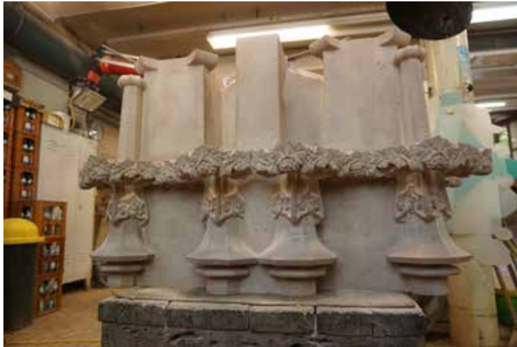
Abb. 45 Eine Hälfte des zweiteiligen Übergangs von der Bekrönung des mittleren polygonalen Fialenbereiches zum oberen quadratischen Fialenbereich (Pos. 5.1a). Fotos 03.02.2022.
