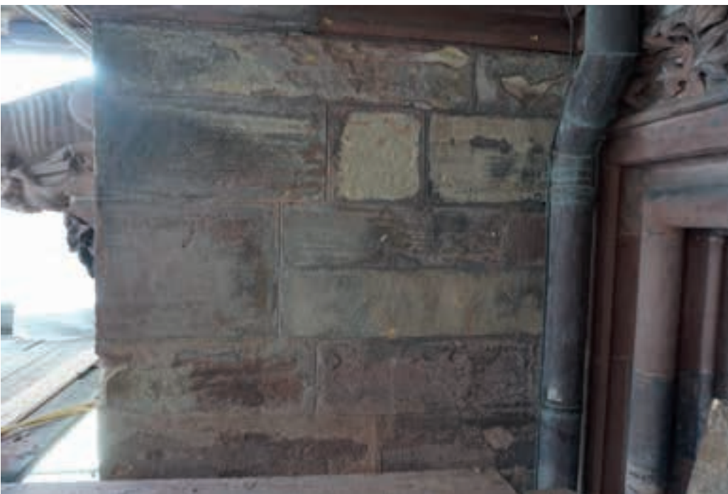
Abb. 46: Zwischenzustand südliche Wandfläche in Höhe Wasserspeier, 28.05.2024 (MBV, S. A. Schedlbauer)
