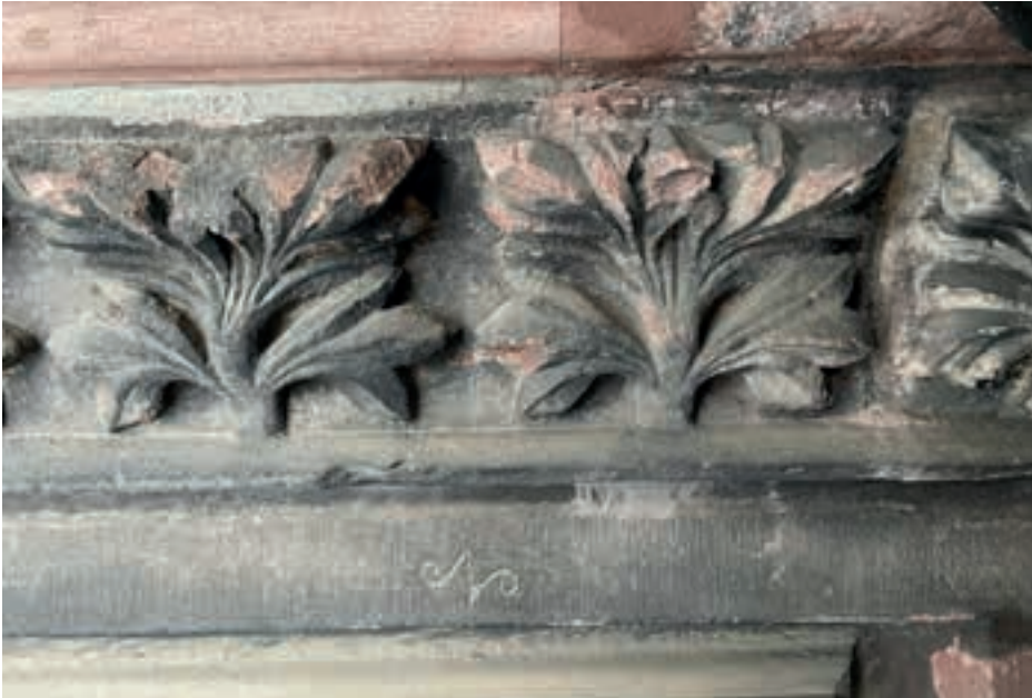
Abb. 65: Teilbereich des Frieses oberhalb des Radfensters im Vorzustand 16.01.2023 (L. Kürten)
