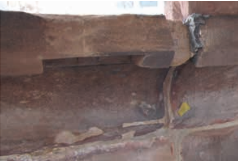
Abb. 37: Fertig vorbereitetes Gesims vor dem Einsetzen der Vierungen, 02.03.2023 (MBV, A. Schedlbauer)
