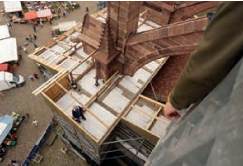
Abb. 95: Fridolin Ortlieb beim Bau der Überdachung, 09.05.2023 (MBV, A. Schedlbauer)
