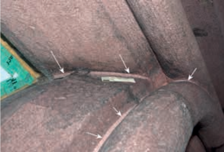
Abb. 62: Die Pfeile zeigen auf verkratzte helle Streifen in der Steinoberfläche, die durch scharfe Werkzeuge beim Entfernen der Farbe entstanden sind, 09.08.2023 (J. Quatmann)
