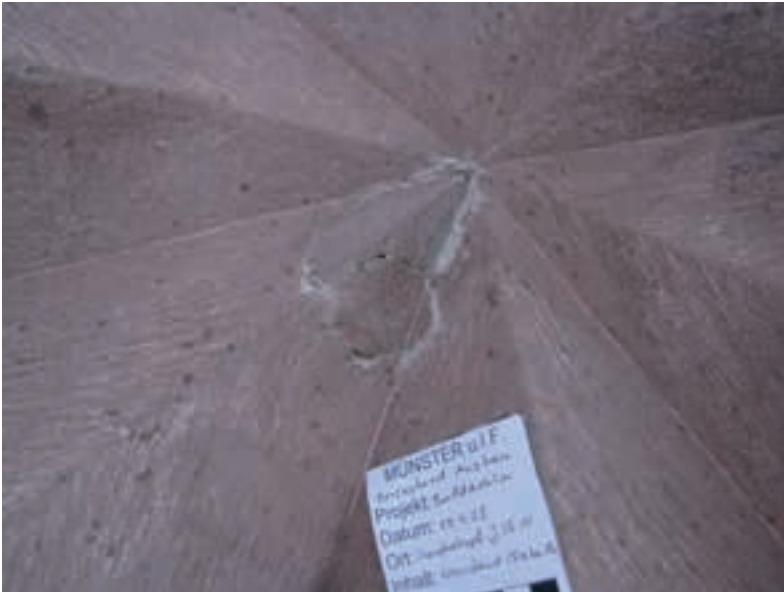
Abb. 23: Mit Vierung kaschiertes Dübelloch, 19.04.2023 (MBV, J. Stöhr)
