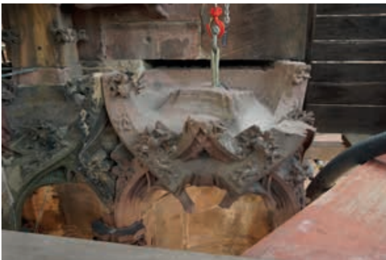
Abb. 24: Herausnehmen des Baldachins mittels Kettenzug, 20.07.2023 (MBV, A. Schedlbauer)
