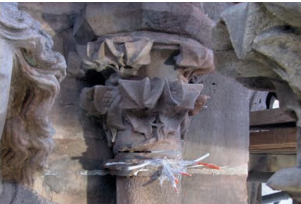
Abb. 54: Injizieren von Mikrozement in die Risse, 29.08.2023 (MBV, A. Schedlbauer)
