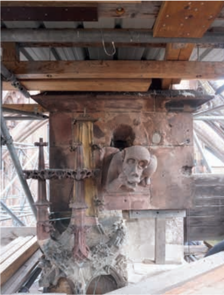
Abb. 27: Zwischenzustand mit konserviertem Wasserspeier, gereinigter Wandfläche und Zierteilen sowie ausgebautem Wasserrohr. Bei den dunklen Belägen im linken Teil der Wandfläche handelt es sich um Braunfärbungen. Hier werden Eisen-Mangan-Verbindungen aus dem Steingefüge an die Oberfläche transportiert, 19.04.2023 (MBV, T. Borsdorf)
