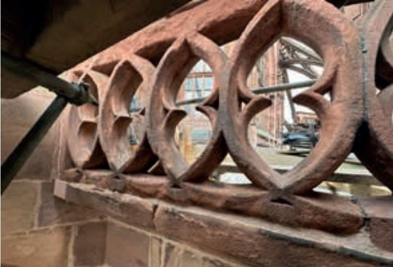
Abb. 40: Maßwerkbrüstung, Joch 14 WS1, Schnewlin-Kapelle, im Endzustand, 30.03.2024 (L. Kürten)
