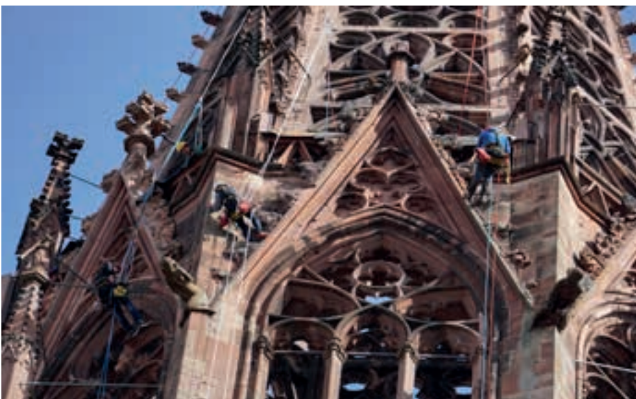
Abb. 86: Die Kletterer im Einsatz am Westturm, 10.10.2023 (MBV, A. Schedlbauer)
