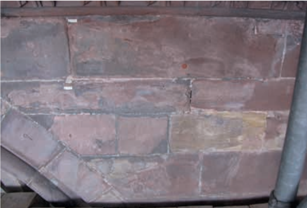
Abb. 81: Vorzustand Wandfläche Joch 1, westlich des Fensters 04.07.2023 (MBV, A. Schedlbauer)
