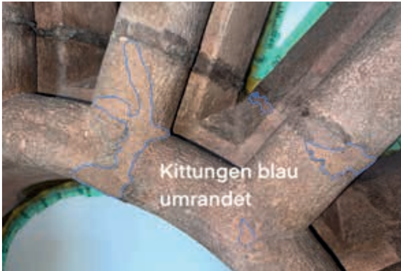
Abb. 74: Aufgetragene Kittungen an dem Radfenster, 07.09.2023 (L. Kürten)
