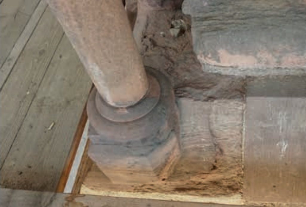
Abb. 75: Fehlstelle an der Standfläche des Apostels Bartholomäus 20.06.2023 (MBV, S. Eberhardt)
