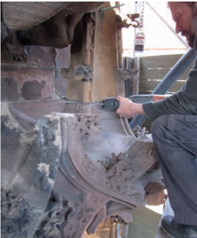
Abb. 22: Joachim Stöhr durchtrennt die Bleifuge, um den Fialaufsatz vom Baldachin nehmen zu können, 03.05.2023 (MBV, A. Schedlbauer)
