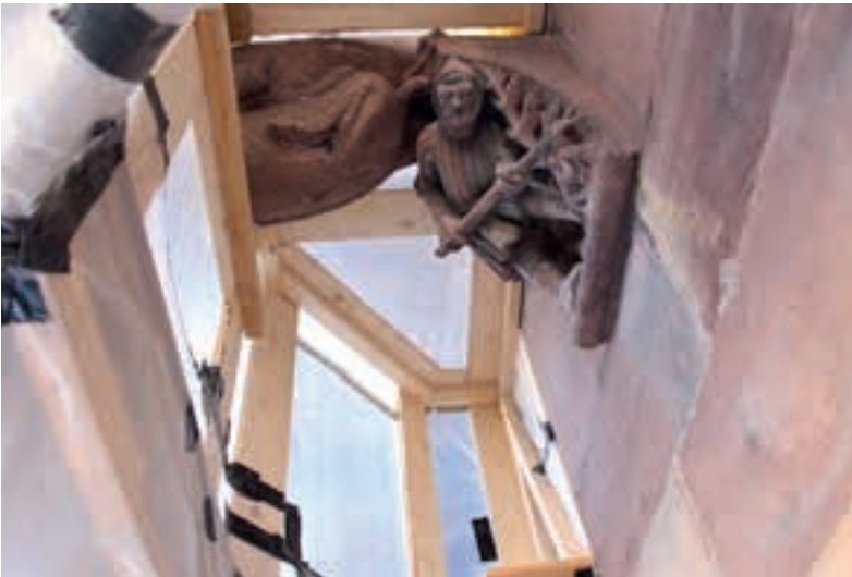
Abb. 92-94: Fertige Staubeinhausung an Strebepfeiler 0/1, 05.12.2023 (MBV, A. Schedlbauer)
