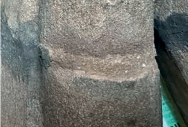
Abb. 73: neue Fuge, die farblich angepasst wurde, 07.09.2023 (L. Kürten)
