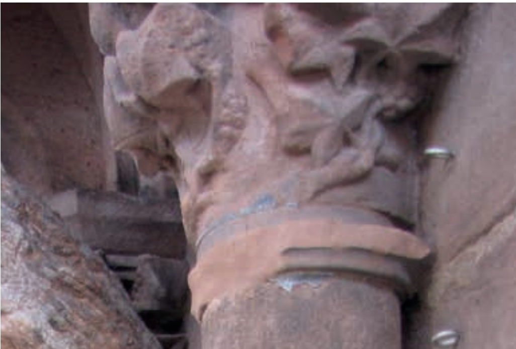
Abb. 56: Das Kapitell nach abschließender Festigung, 14.09.2023 (MBV, A. Schedlbauer)
