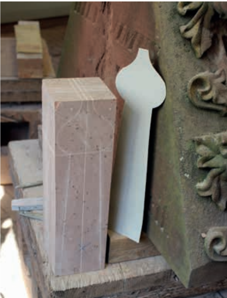
Abb. 5: Knauf für die hintere Kreuzblume des Pfeileraufsatzdaches, 02.05.2023 (MBV, A. Schedlbauer)
