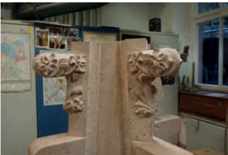
Abb. 10: Der untere Helmspitzstein. Die Distelform, die im oberen quadratischen Fialenbereich erscheint, wird nach oben in die Pfeileraufsatzspitze weitergeführt, 04.12.2023 (MBV, A. Schedlbauer)
