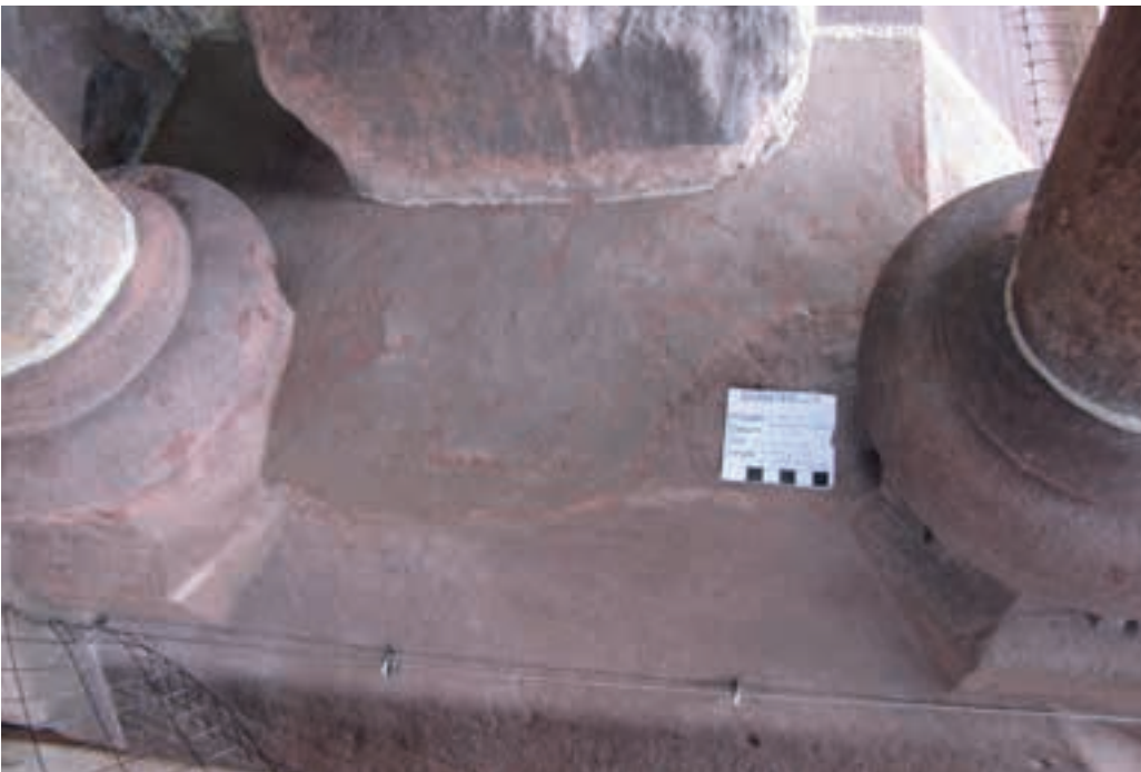
Abb. 78: Fertige Kittung vor Anbringung des Taubenschutzes 21.11.2023 (MBV, S. Eberhardt)
