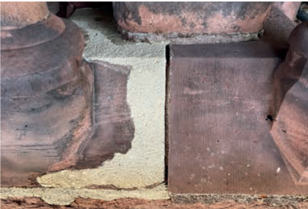
Abb. 76: Mörtelantragung 21.06.2023 (MBV, S. Eberhardt)
