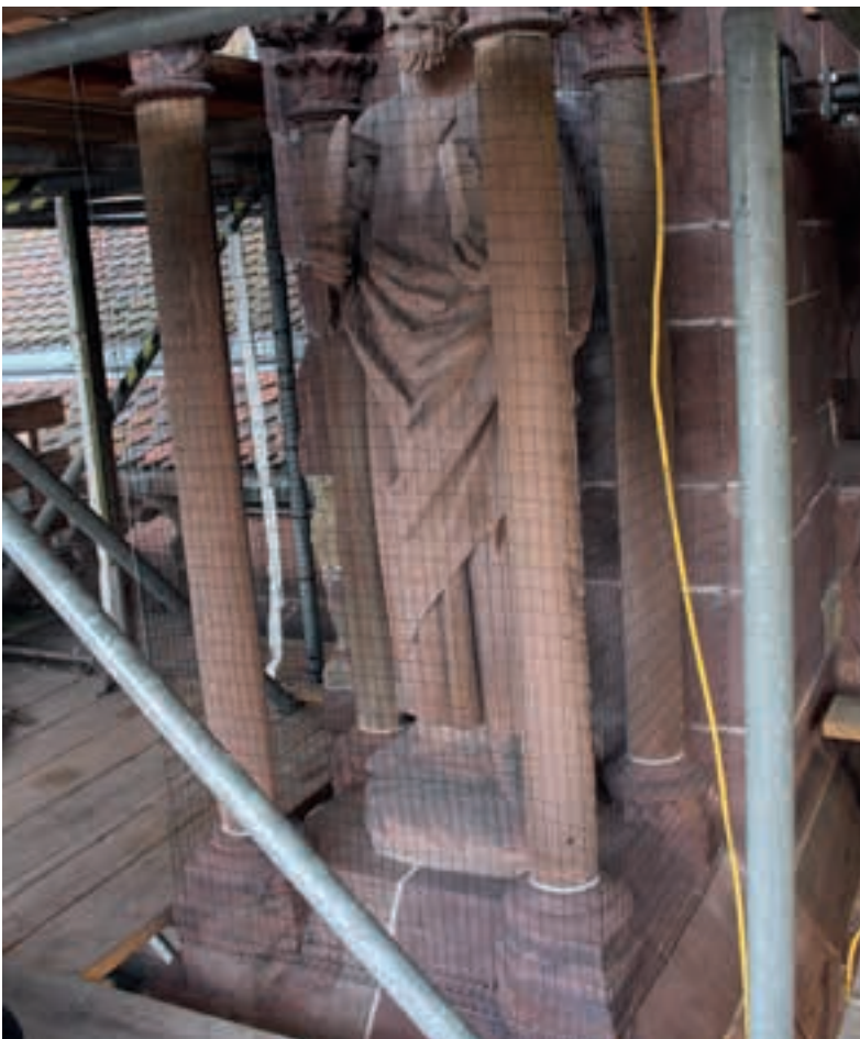
Abb. 97: Taubenschutznetz an Strebe Pfeiler 1/2, 05.12.2024 (MBV, A. Schedlbauer)
