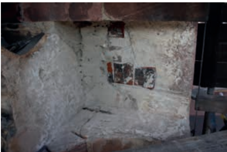
Abb. 25: Von Mörtel befreite Nische, klar sind die Klammerreste zu erkennen, 19.09.2023 (MBV, A. Schedlbauer)
