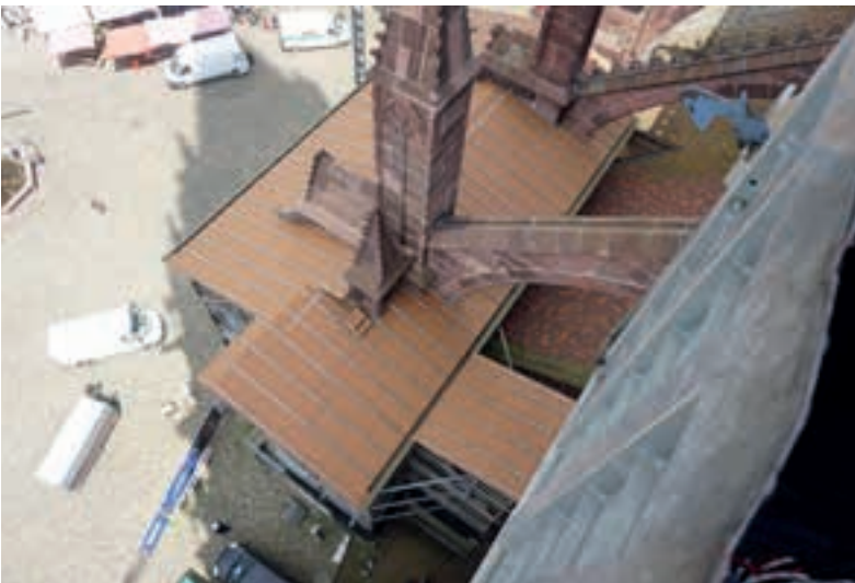
Abb. 96: Fertige Gerüstüberdachung, 24.06.2024 (MBV, A. Schedlbauer)
