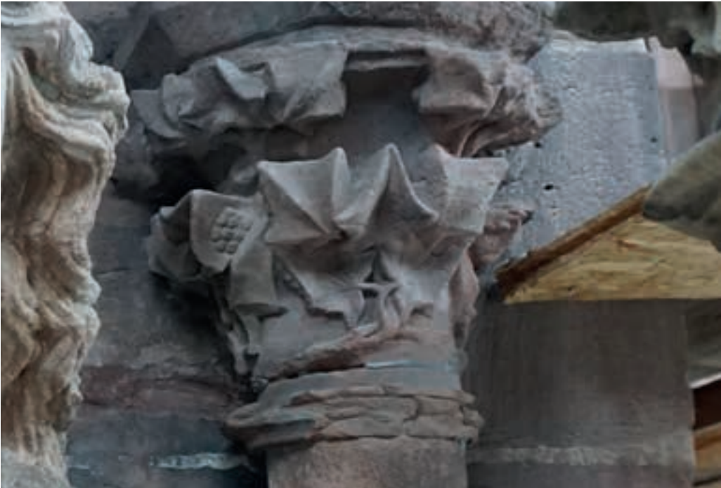
Abb. 53: Schichtparallele Risse an einem der Kapitelle 24.03.2023 (MBV, A. Schedlbauer)
