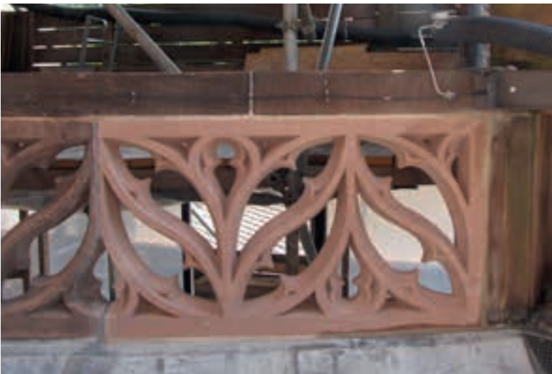
Abb. 30: Fertig verfugter Stein, 12.07.2023 (MBV, A. Schedlbauer) Münster ULF Freiburg i. B. | Arbeitsdokumentation 2023 | Freiburger Münsterbauverein e.V.
