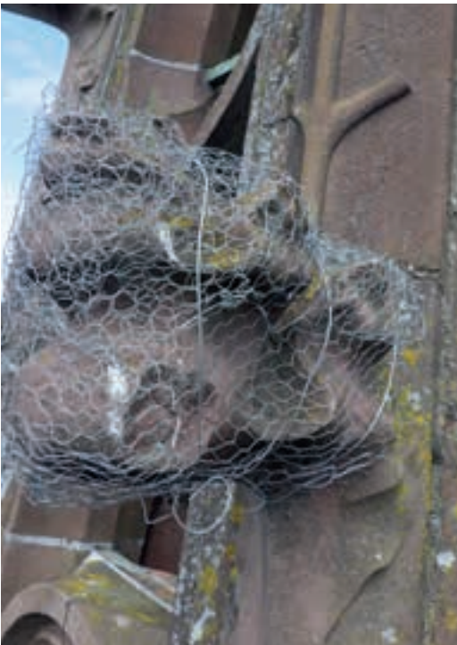
Abb. 88: Oben gezeigte Krabbe, nun mit Draht gesichert, 31.07.2023 (MBV, T. Borsdorf)
