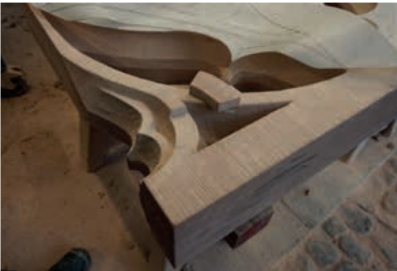
Abb. 31: Ein Toneinschluss im Maßwerk wurde ausgearbeitet und ein millimetergenau eingepasstes Steinstück zum Einkleben vorbereitet, 25.04.2023 (MBV, A. Schedlbauer)
