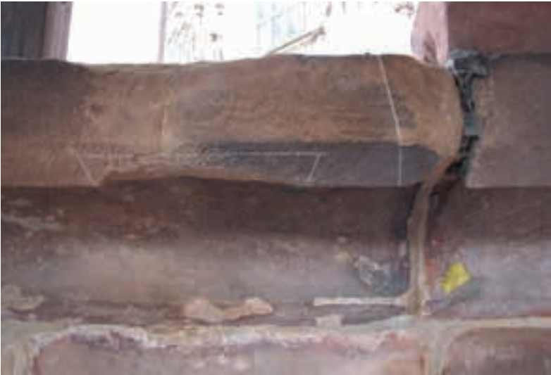
Abb. 36: Anzeichnen der abzuspitzenden Flächen, 23.02.2023 (MBV, A. Schedlbauer)
