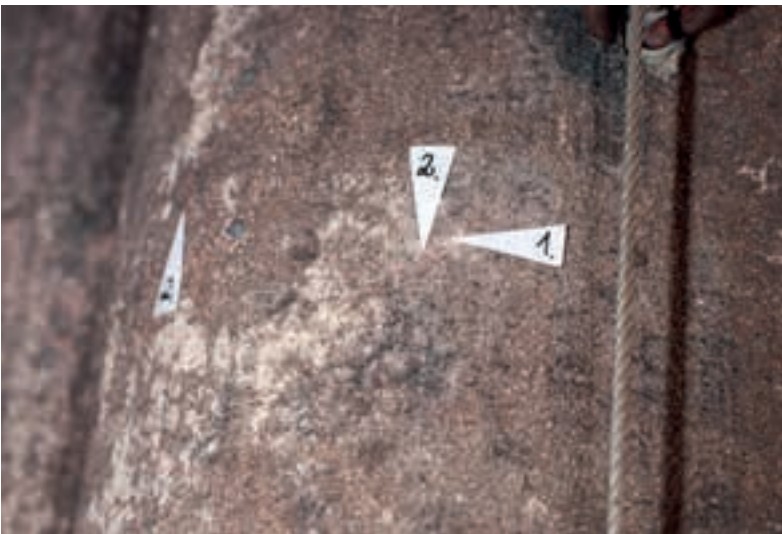
Abb. 63: Ehemals mit Säure behandelte und verwitterte Oberfläche mit Farbspuren, 05.05.2023 (J. Quatmann)
