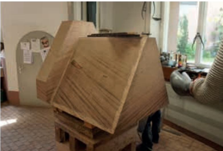
Abb. 2: Rückseitiger Giebel des Pfeileraufsatzdaches. Deutlich zu erkennen der große Toneinschluss an einer der Dachschrägen, 30.08.2023 (MBV, A. Schedlbauer)
