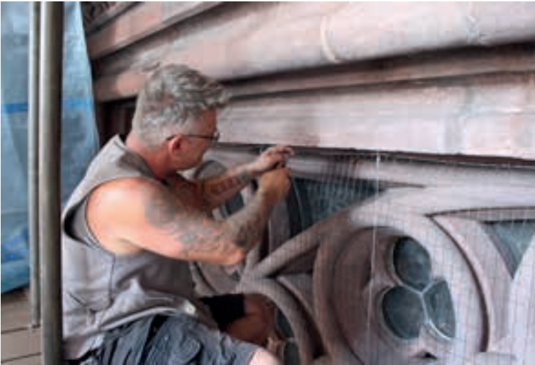
Abb. 98: Thomas Prinich beim Anbringen des Edelstahlnetzes, 11.10.2023 (MBV, A. Schedlbauer)
