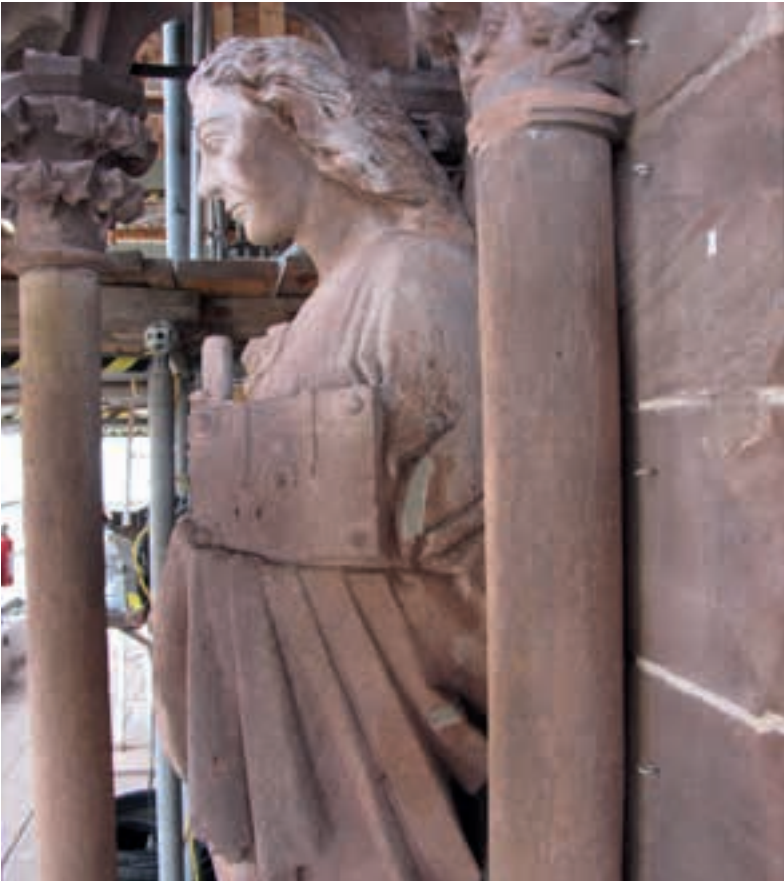
Abb. 51: Mit Kernaufbaumörtel gefüllte Tonlinse an der Jakobus-Figur, 14.09.2023 (MBV, A. Schedlbauer)
