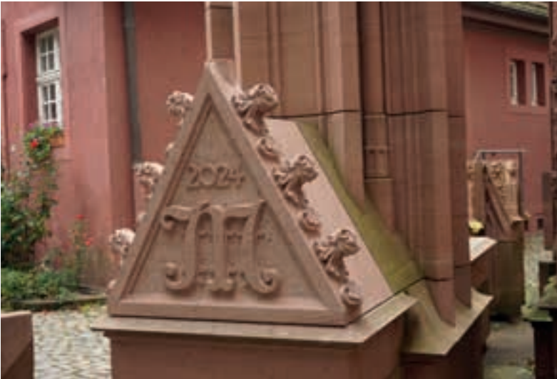
Abb. 1: Vorderseitiger Giebel des Pfeileraufsatzdaches mit Spiegelinschriften, 30.10.2023 (MBV, A. Schedlbauer)
