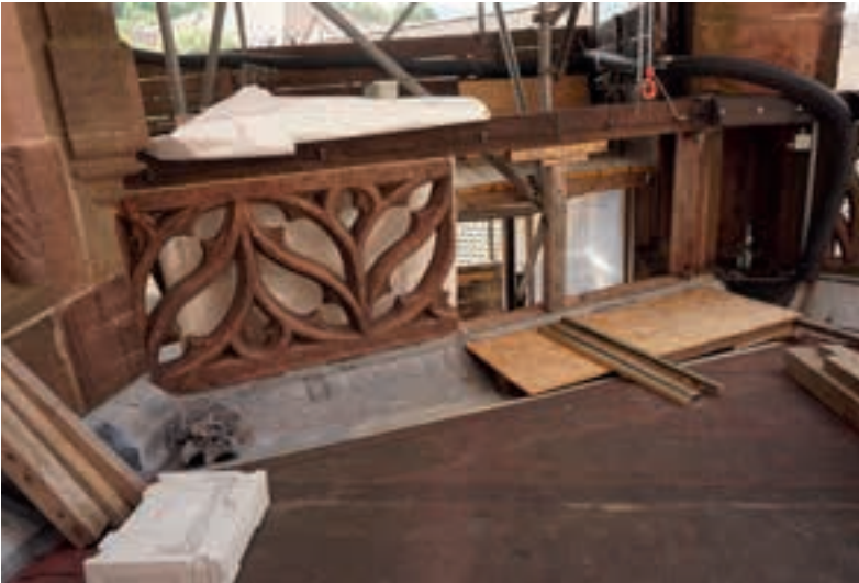
Abb. 28: Situation vor dem Einbau der neu geschlagenen Maßwerksbrüstung, 20.06.2023 (MBV, A. Schedlbauer)
