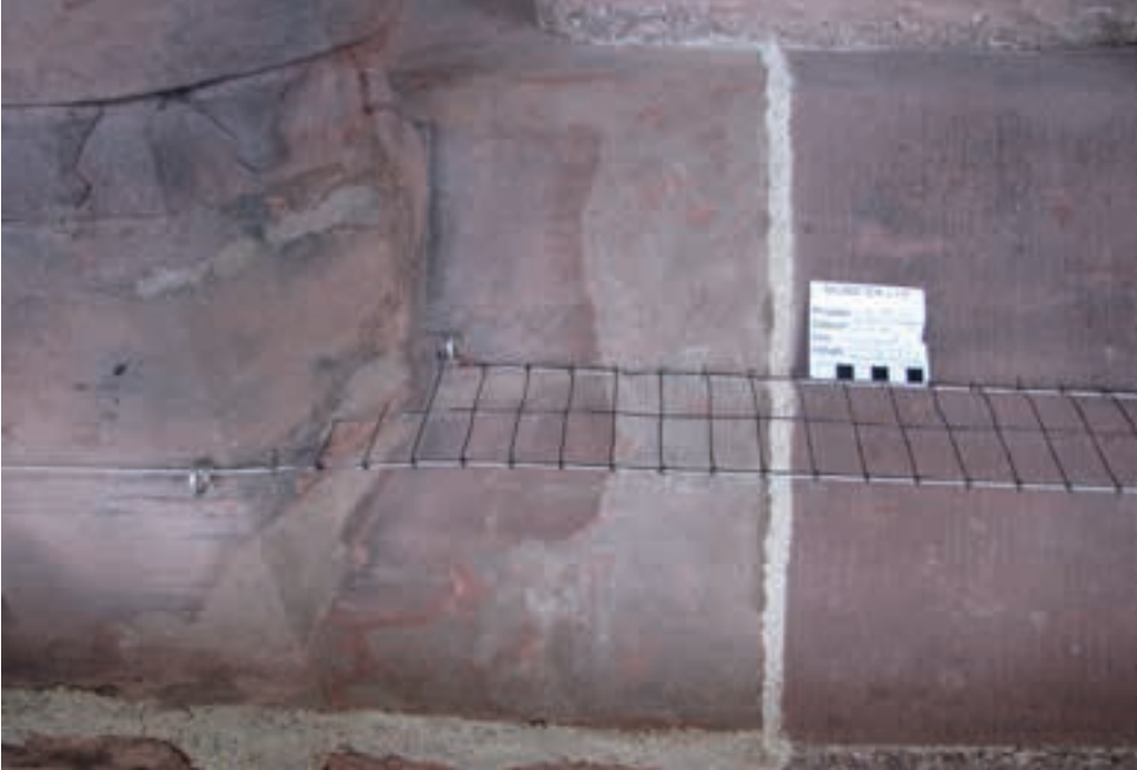
Abb. 77: Fertige Kittung vor Anbringung des Taubenschutzes 21.11.2023 (MBV, S. Eberhardt)
