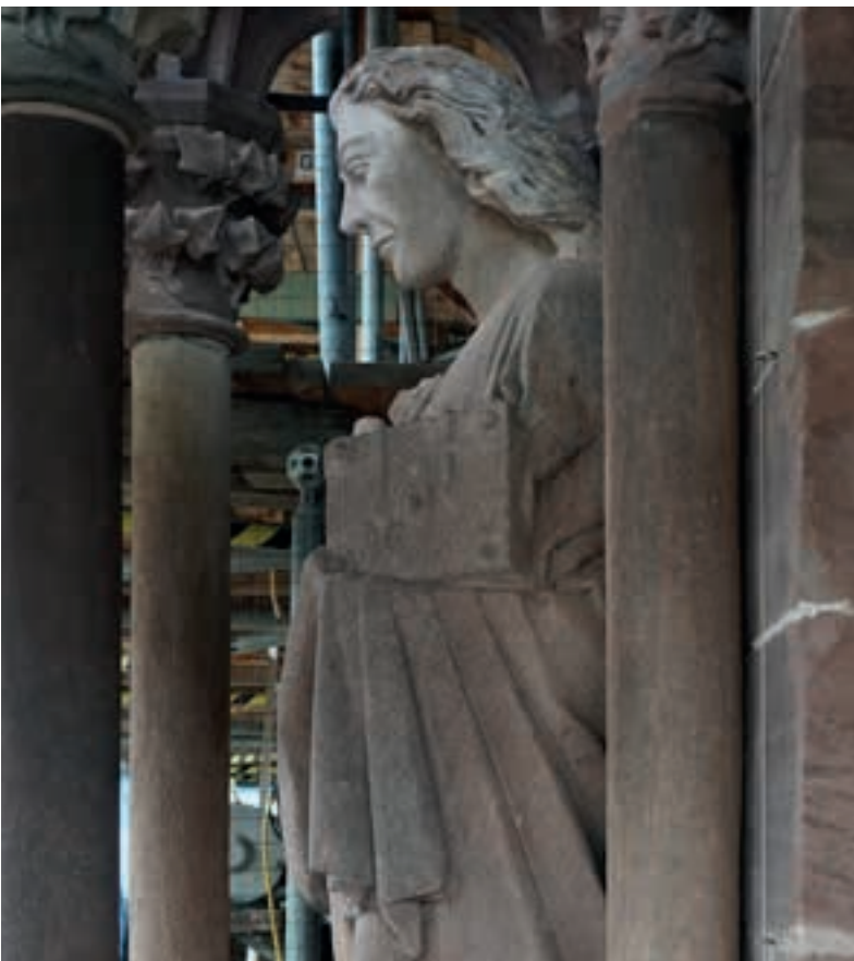
Abb. 52: Abschließend wurden die Einschlüsse mit Kittmasse abgedeckt, 09.11.2023 (MBV, A. Schedlbauer)
