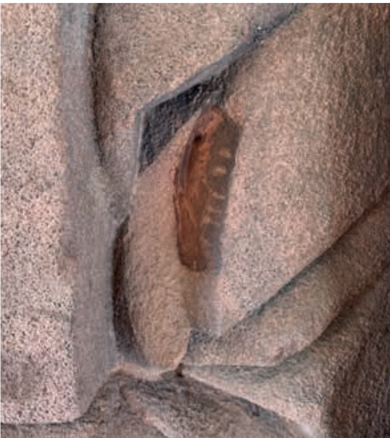
Abb. 49+50: Detailaufnahme Tonlinsen an der Jakobus-Figur, 09./10.08.2022 (MBV, T. Borsdorf) Münster ULF Freiburg i. B. | Arbeitsdokumentation 2023 | Freiburger Münsterbauverein e.V.
