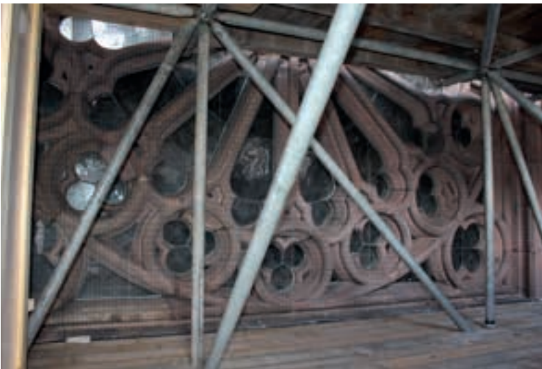
Abb. 99: Fertig eingenetzes Rosenfenster, 05.12.2024 (MBV, A. Schedlbauer)
