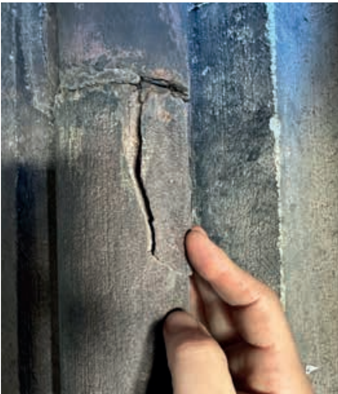
Abb. 69: Bruchteil, das durch Korrosionsdruck entstanden ist, 04.09.2023 (L. Kürten)
