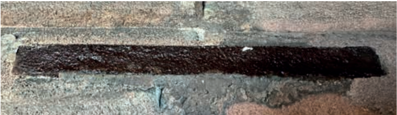
Abb. 70: Behandlung einer Eisenklammer, 07.09.2023 (L. Kürten)
