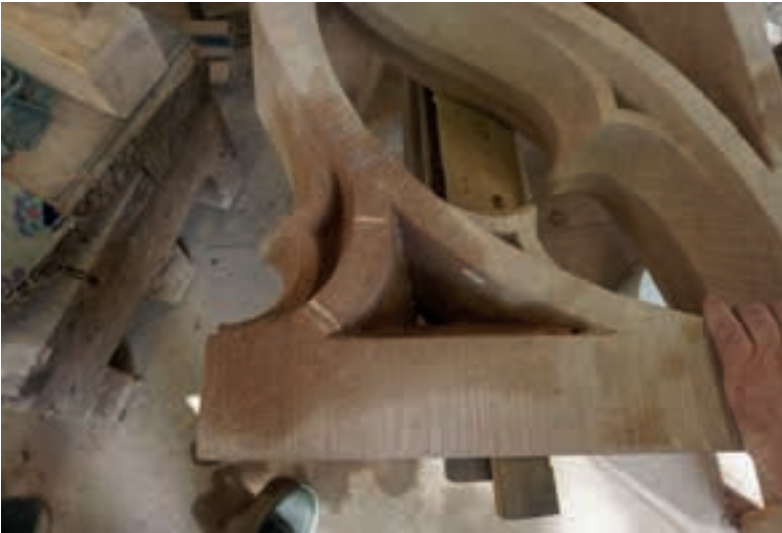
Abb. 32: Die mit Naturharz verklebte und bereits angearbeitete Vierung am Maßwerksteg, 04.05.2023 (MBV, A. Schedlbauer)
