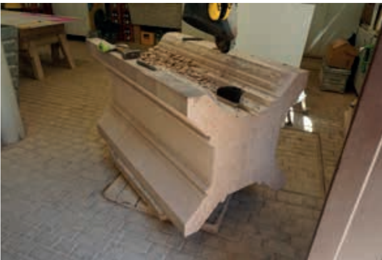
Abb. 17: Der Schaft vom quadratischen Fialenbereich in Arbeit, 14.06.2023 (MBV, A. Schedlbauer)
