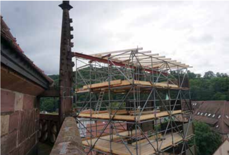
Abb. 36: Mit einer leichten Neigung nach Westen wurde oberhalb der Kranbahn mit dem 30 Meter langen elektrischen Kettenzug ein Dach aus Trapezblechen auf eine hölzerne Unterkonstruktion montiert 04.07.2024 (MBV, A. Schedlbauer)
