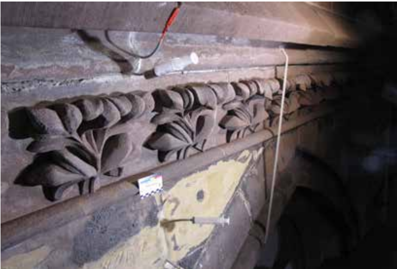
Abb. 3: Rissinjektion 17.12.2024 (MBV, S. Eberhardt)
