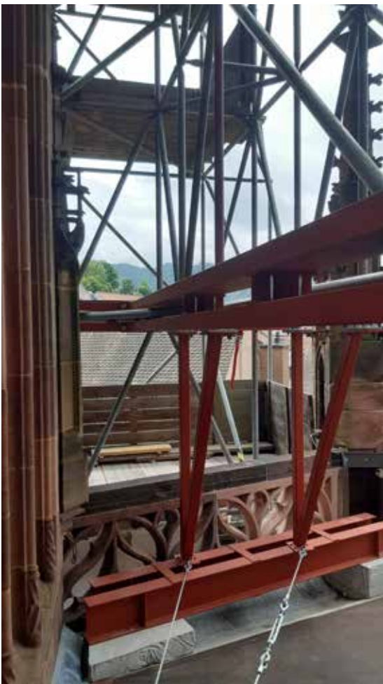
Abb. 30: Auflagerung des Gerüstes 17.06.2024 (MBV, A. Schedlbauer)
