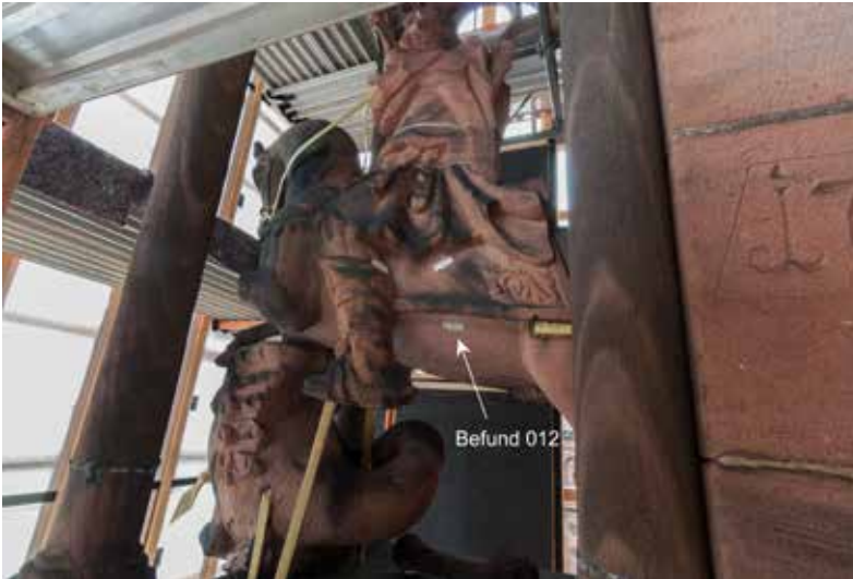
Abb. 5: Ostansicht des Reiterstandbilds. Lage von Befundstelle 012 13.09.2024 (J. Quatmann)
