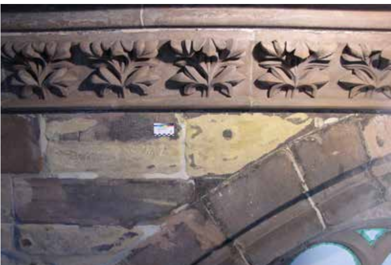
Abb. 4: Endzustand 13.01.2024 (MBV, S. Eberhardt)
