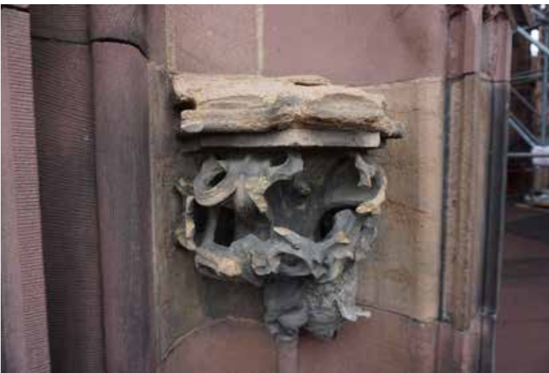
Abb. 6: ... und nach der Abnahme 25.09.2024 (MBV, H. Koch)
