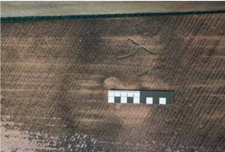
Abb. 14: Eines der wenigen Steinmetzzeichen, Steinoberfläche sauber scharriert 25.09.2024 (N. Koch)
