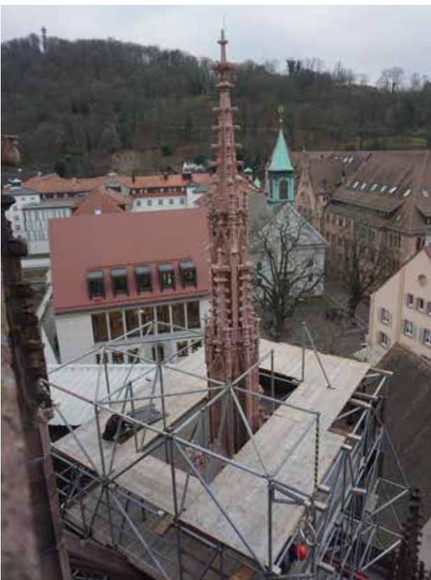
Abb. 44: Auf Höhe des polygonalen Fialbereiches verschwinden die Böden und geben nach und nach die Sicht auf den ganzen Pfeileraufsatz frei. 11.12.2024 (MBV, A. Schedlbauer)
