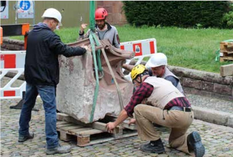
Abb. 15: Die bereits 2023 ausgebaute rechte Baldachinhälfte wird mit Hilfe eines Kranwagens aus dem engen Gerüst herausgefädelt und auf den Münsterplatz abgelassen (Pos. 10.4). 02.07.2024 (MBV, A. Schedlbauer)
