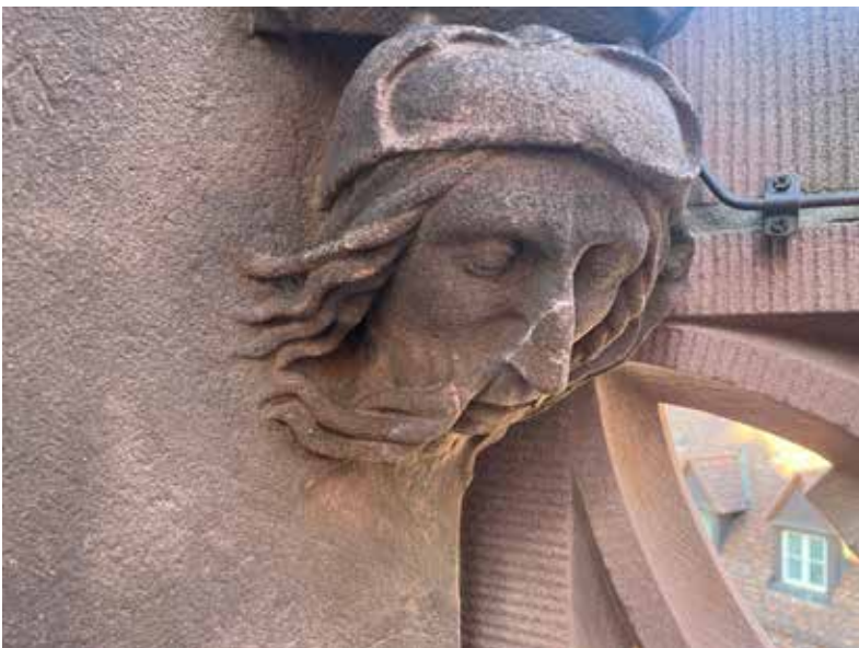
Abb. 5: Zwischenzustand mit angeklebter Nase 21.10.2024 (MBV, T. Borsdorf)
