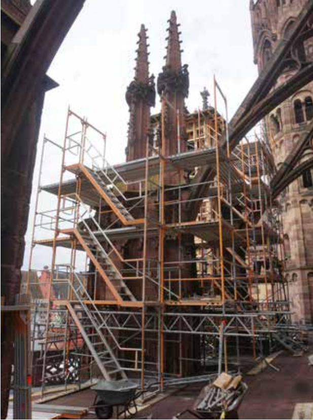
Abb. 2: Untersuchungsgerüst während des Aufbaus, das vorübergehend auch der Sicherung gegen abstürzende Teile dient. 01.08.2024 (MBV, A. Schedlbauer)
