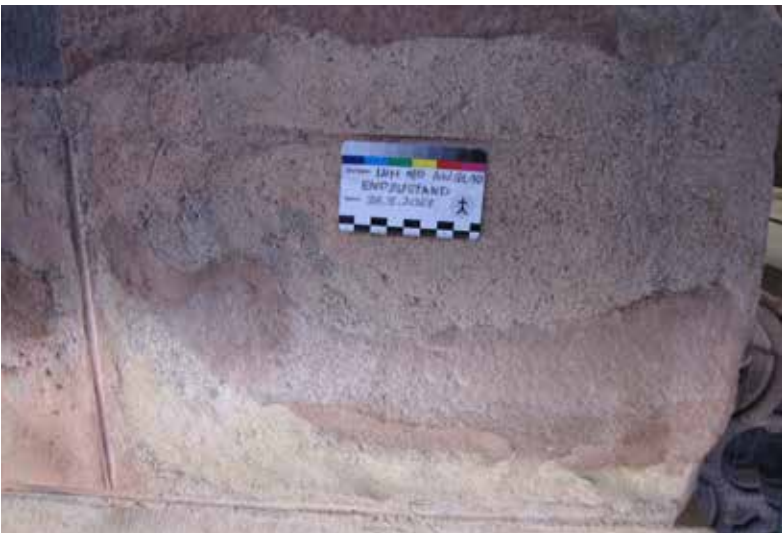
Abb. 3: Endzustand, Westwand unterhalb des Wasserspeiers 28.08.2024 (MBV, S. Eberhardt)
