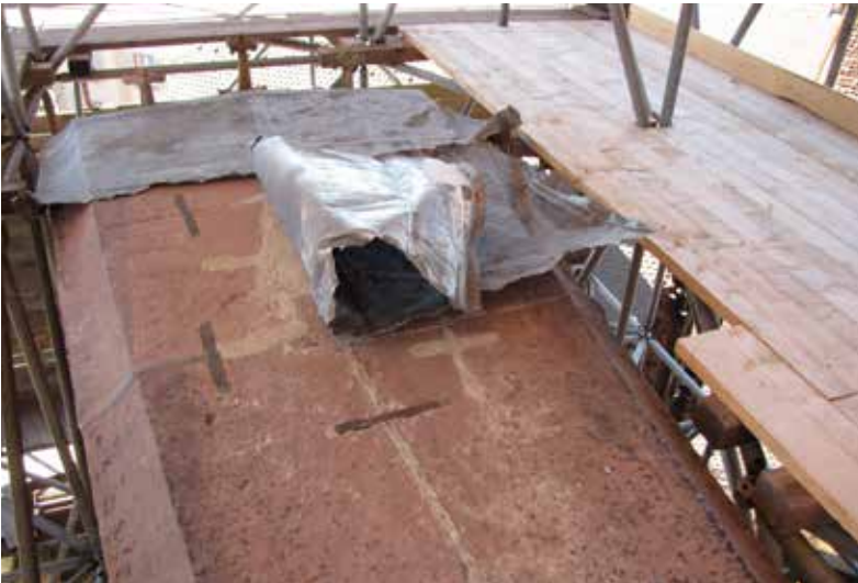
Abb. 37: Die provisorische Walzbleiabdeckung der Pfeilerabdeckung wird vor dem Steinversatz entfernt. 09.07.2024 (MBV, A. Schedlbauer)
