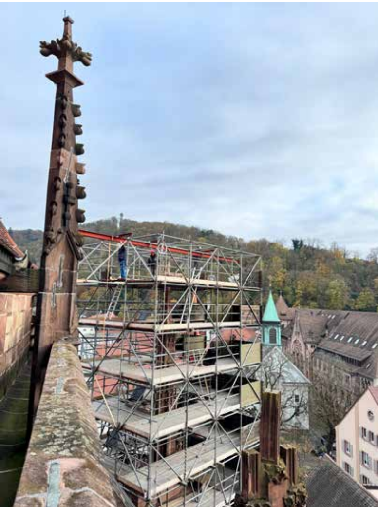
Abb. 40: Das Gerüst nach dem Versatz der letzten Steine und Abnahme der Dachkonstruktion 14.11.2024 (MBV, A. Schedlbauer)
