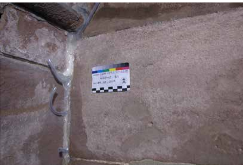
Abb. 4: Arbeiten an der Eckfuge am Übergang zu Joch 1 04.11.2024 (MBV, S. Eberhardt)
