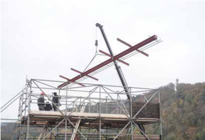
Abb. 41: Die Kranbahn wird abgelassen und für das nächste Gerüst eingelagert. 14.11.2024 (MBV, A. Schedlbauer)
