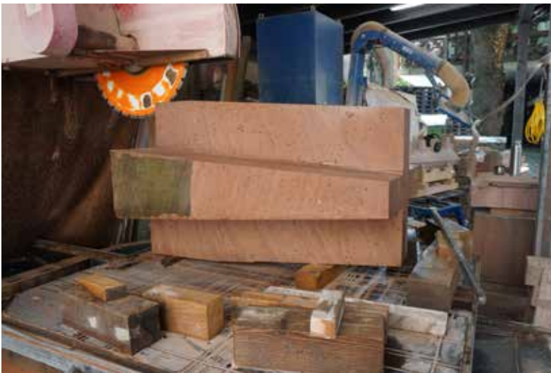
Abb. 2: Vorarbeiten mit der Brückensäge für eine der großen Fialen des oberen quadratischen Bereiches 30.04.2024 (MBV, A. Schedlbauer)
