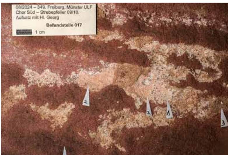
Abb. 4: Ostansicht der mittelalterlichen Pfeilerwand, Ostansicht. Befund 017.
