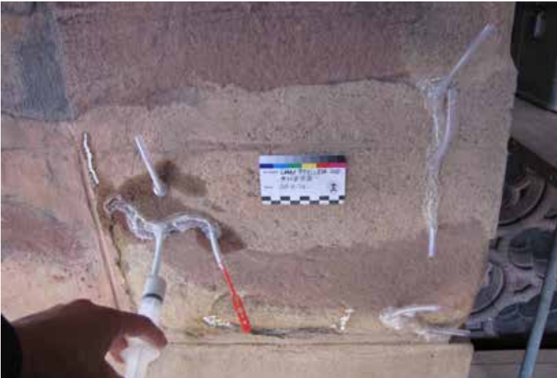
Abb. 2: Bei der Rissinjektion 20.08.2024 (MBV, S. Eberhardt)
