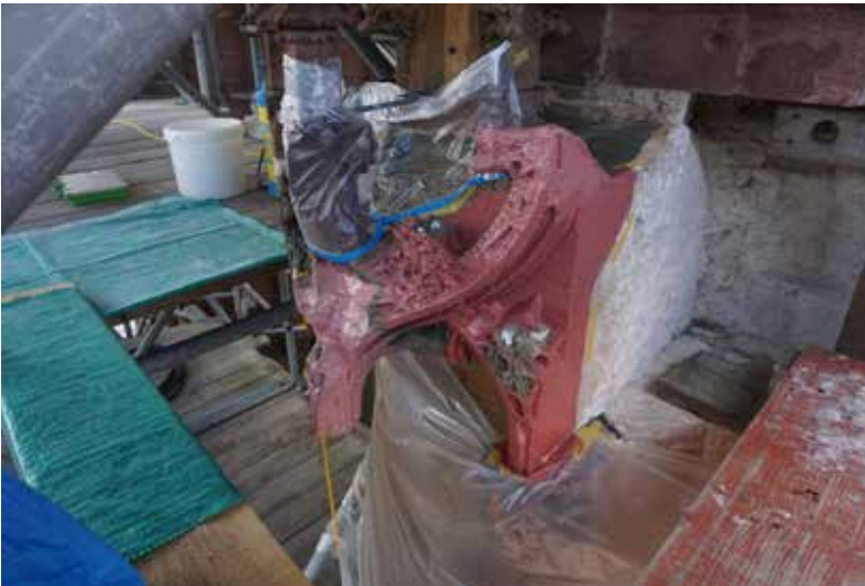
Abb. 18: Mit Hilfe einer Gipsabformung am Anschluss des benachbarten Steines wurden die vormaligen Überzähne des Profils an der mittleren Stoßfuge angepasst. 22.07.2024 (MBV, J. Stöhr)
