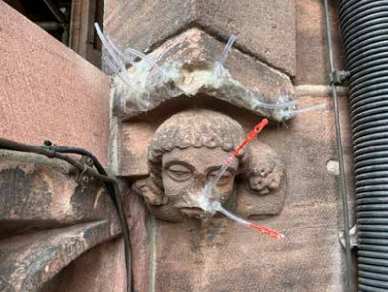
Abb. 2: Zwischenzustand mit Vorbereitung zur Rissinjektion 23.07.2024 (MBV, T. Borsdorf)
