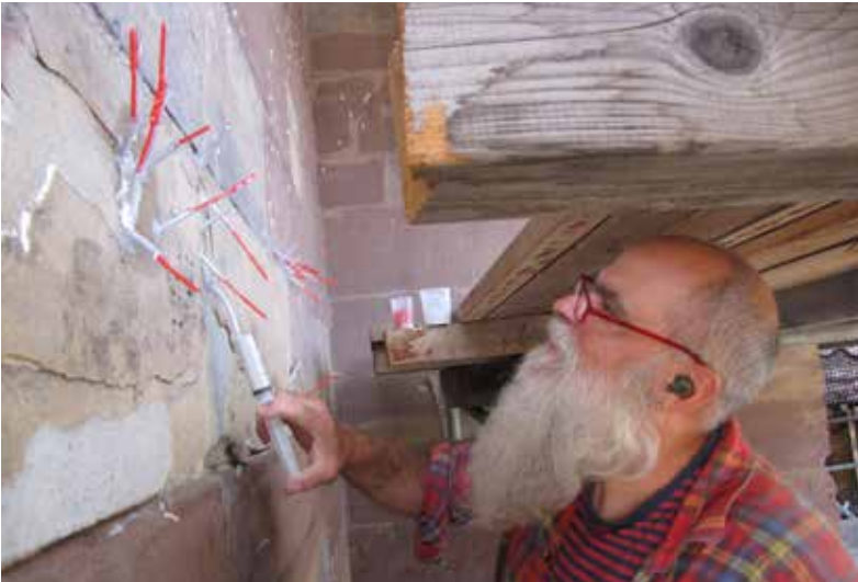
Abb. 2: Bei der Rissinjektion. Vorne links im Bild ist der Kernaufbaumörtel zu erkennen. 21.08.2024 (MBV, S. Eberhardt)
