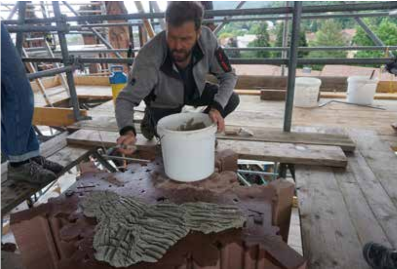
Abb. 39: Der polygonale Fialenbereich wird aufgemauert 21.08.2024 (MBV, A. Schedlbauer)
