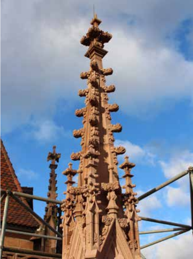
Abb. 43: Der Pfeileraufsatzhelm 28.11.2024 (MBV, A. Schedlbauer)
