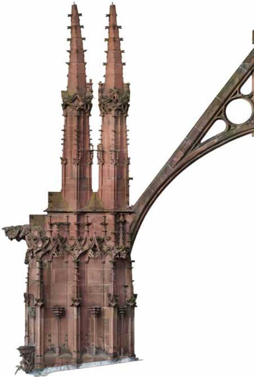
Abb. 1: Orthofoto der Ostansicht des Pfeilers 10/11 Süd 17.10.2022 (dotscene)
