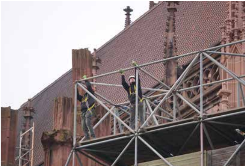
Abb. 42: Nachmittags, wenn der Markt beendet ist wird die Durchfahrt auf den Münsterplatz gesperrt und die äußeren Stäbe werden demontiert. 17.12.2024 (MBV, A. Schedlbauer)
