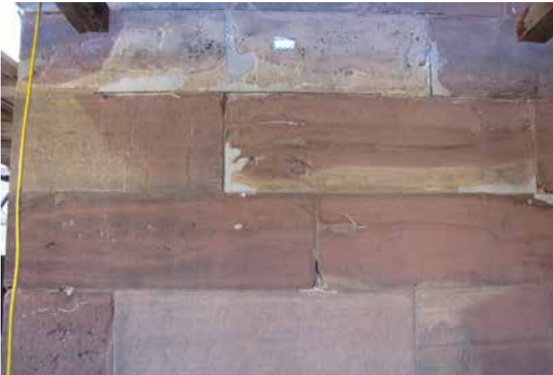
Abb. 3: Zwischenzustand vor dem Kitten 12.09.2024 (MBV, H. Walz)
