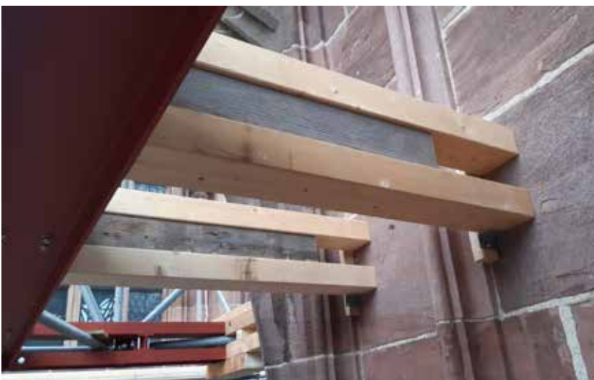
Abb. 32: Die horizontale Gerüsthaltung erfolgt über diesen Stahlrahmen, der den Chorpfeiler umschließt und mit Holzbalken einklemmt. 21.06.2024 (MBV, A. Schedlbauer)
