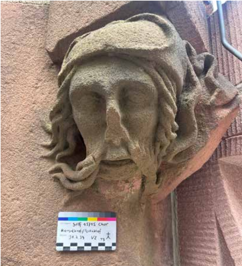
Abb. 4: Konsolkopf am Strebepfeiler 15/15, Vorzustand 31.07.2024 (MBV, T. Borsdorf)
