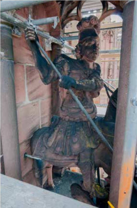
Abb. 1: Reiterstandbild in angetroffenem Zustand 02.07.2024 (J. Quatmann)
