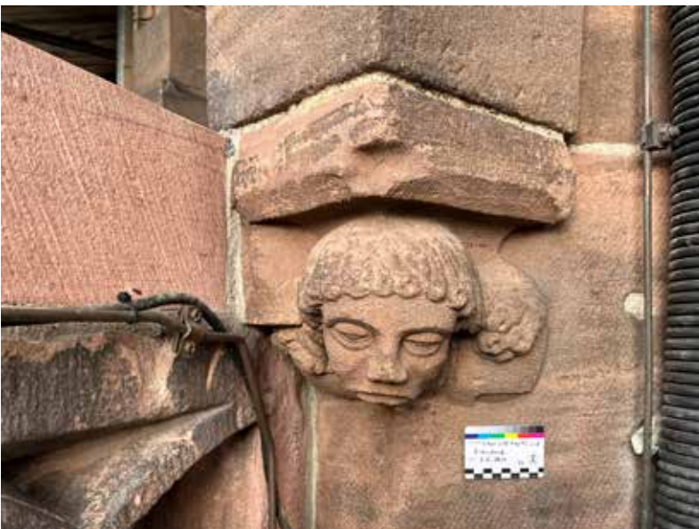
Abb. 3: Endzustand mit angefügter Nase und Kittungen auf sandenden Bereichen 07.08.2024 (MBV, T. Borsdorf)
