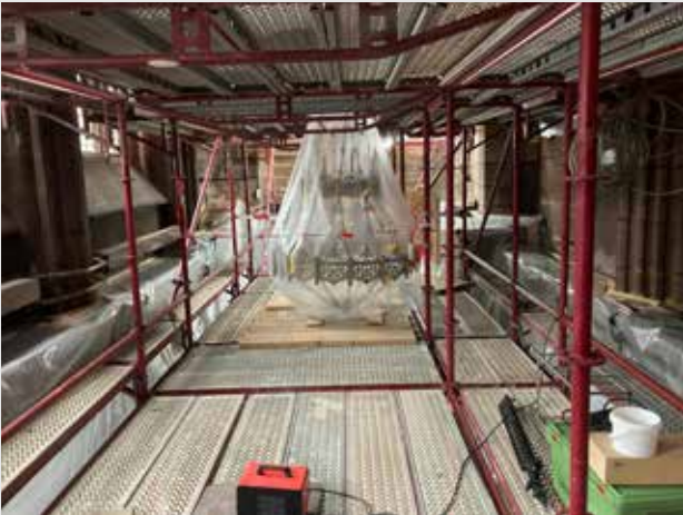
► Abb. 2: Vor der Reinigung der Wandflächen wurden vom Raumgerüst aus sämtliche Ausstattungsgegenstände vor weiteren Verschmutzungen verpackt und geschützt.
