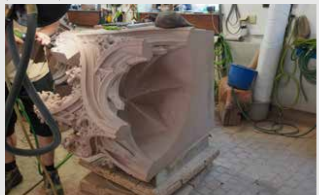
► Abb. 14: Südlicher Chorstrebepfeiler 14/15: rechte, inzwischen fertiggestellte Baldachinhälfte (23.01.2025).
