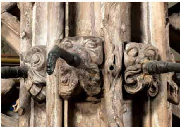
► Abb. 8: Wasserspeier oberhalb der unteren Brunnenschale.
