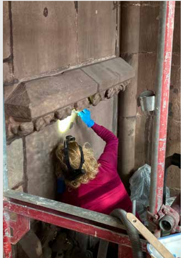
► Abb. 3: Das von unten mit Blattwerk reliefierte Gesims über dem Eingang zum Chorumgang wird von der Restauratorin Silke Günther in den Tiefen gereinigt.
