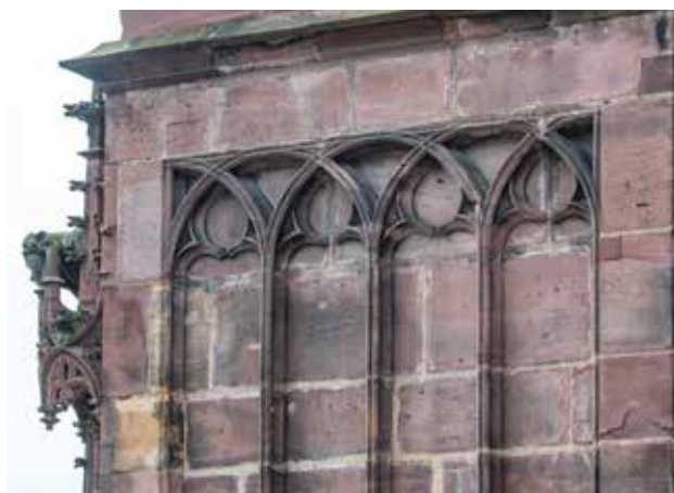
► Abb. 18: Blendmaßwerk am Chorstrebpfeiler 11/12 Süd.
