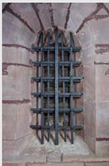
► Abb. 7: Die Aufnahme zeigt das Gitter nach der Reinigung und Konservierung. Da die Wandflächen zwischen den Gittern nicht, wie die anderen Wandflächen, Ende des 19. Jahrhunderts freigelegt wurden, haben sich auf der Fensterlaibung die farbigen Anstriche flächig erhalten.
