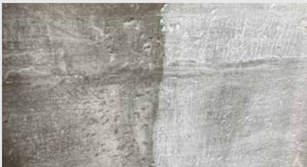
► Abb. 4: Durch die Reinigung der Decke mit einer Latexpaste (rechte Seite nach der Reinigung) wurde ein deutlicher Reinigungserfolg erzielt.
