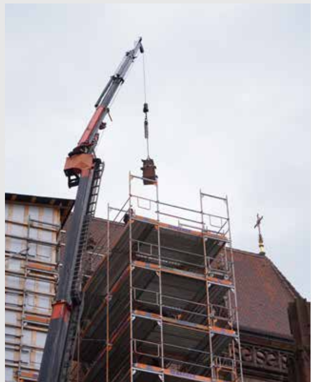
► Abb. 10: Die obersten Steine der Fialen des Strebepfeileraufsatzes 10/11 Süd werden vorsorglich abgenommen (23.04.2025).
