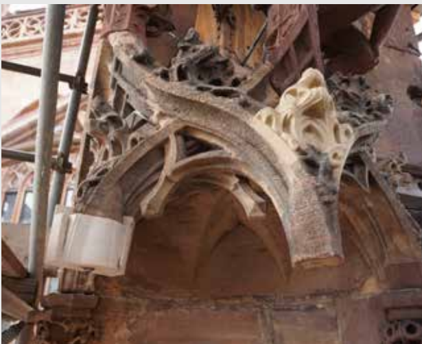
► Abb. 17: Südlicher Chorstrebebepfeiler 14/15: Das eingebaute Passstück. Daneben ebenfalls ein Passstück zur Anbringung des neugeschlagenen Abhänglings (06.08.2025).
