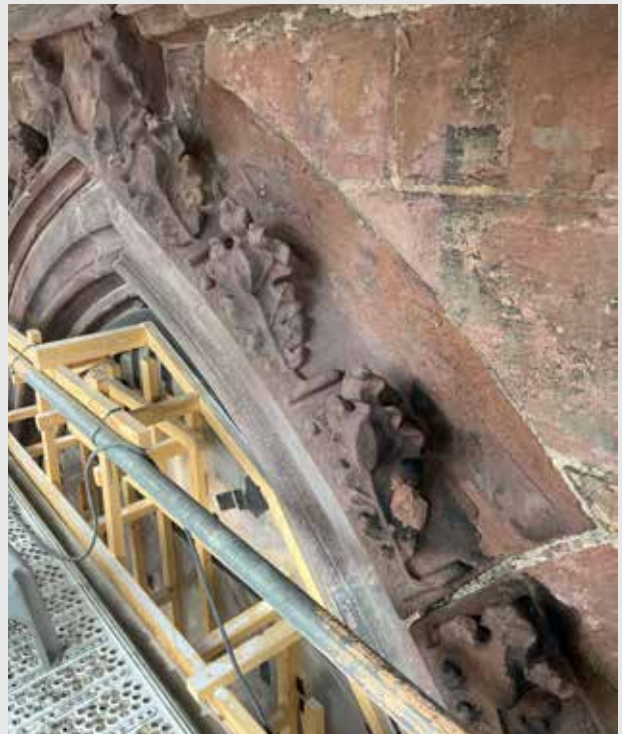
► Abb. 22: Das Laubwerk über dem Fensterbogen der Peter-und-Pauls-Kapelle nach der konservatorischen Reinigung (22.9.2025)
