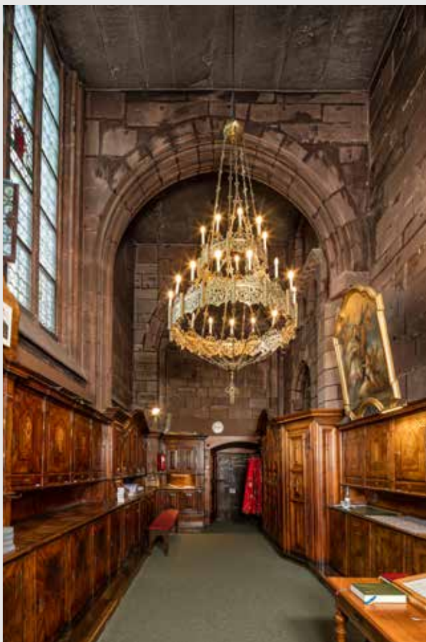
► Abb. 1: Das Foto zeigt die Sakristei mit Blick in Richtung Westen zum Querhaus im Vorzustand. In der Seitenwand sind die romanischen Bögen der südlichen Hahnenenturmwand erkennbar. Die Decke besteht aus massiven Steinplatten, die auf Schwibbögen aufgelegt sind.
