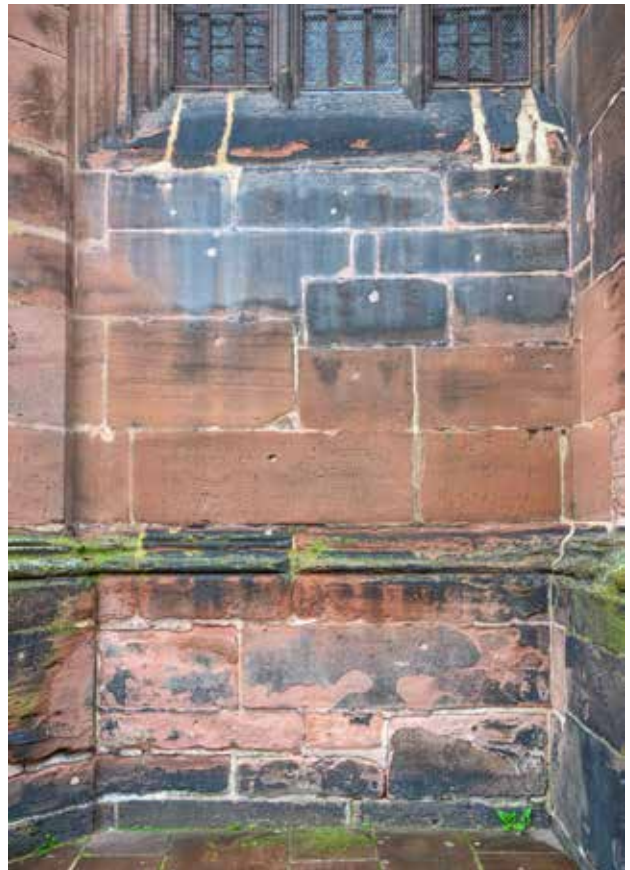
► Abb. 2: Der Sockelbereich am Übergang zum Strebepfeiler mit Baufuge.
