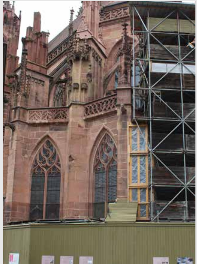
► Abb. 12: Konservatorisch überarbeitet und freigelegt: Die beiden angrenzenden Kapellenwandflächen, die mit dem Gerüst für den Chorstrebepfeileraufsatz 13/14 verbaut waren (21.07.2025).
