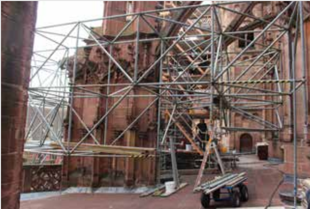
► Abb. 8: Das Arbeitsgerüst für den südlichen Chorstrebepfeiler 10/11 Süd während des Aufbaus (21.07.2025).
