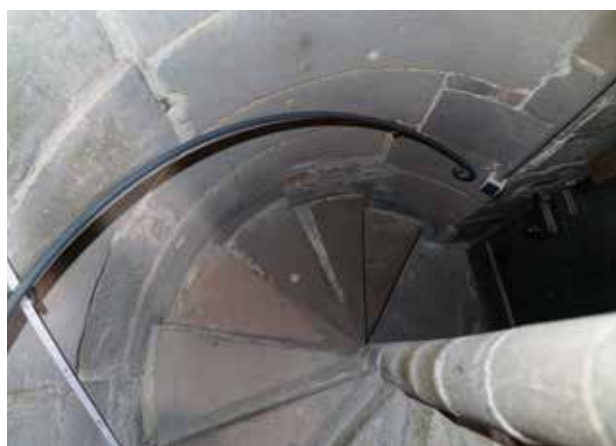
► Abb. 9: Die untersten Treppenstufen an der Heimhofer-Kapelle mit deutlichen Zeichen von Zweitverwendung.
