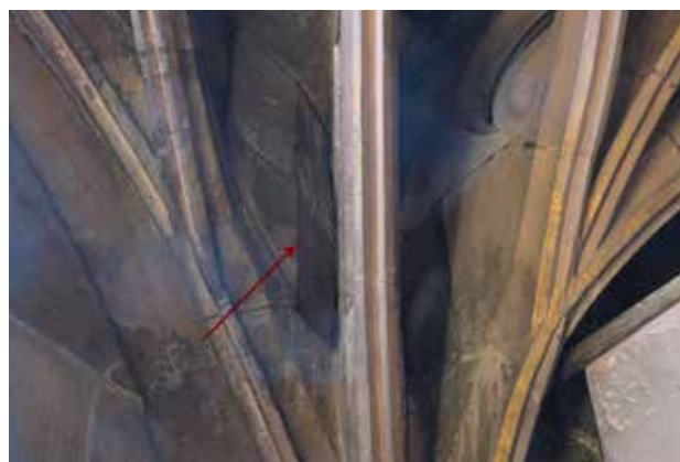
► Abb. 11: Gewölbe in der nordöstlichen Ecke der Ölberg-/Grafenkapelle; Pfeil: schräg abgearbeitete Wandfläche.
