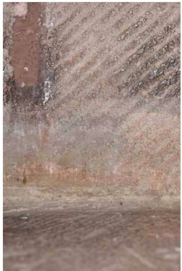
► Abb. 3: Reinigungsprobe zu dunklen Ablagerungen oberhalb der Sitzbankflächen.
