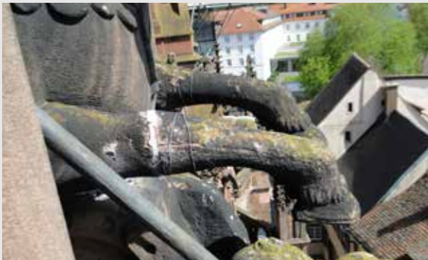
► Abb. 4: Riss am Vorderlauf des Pferds, Reiterstandbild des Heiligen Georg, Strebesystem 9/10 Süd (16.01.2024).
