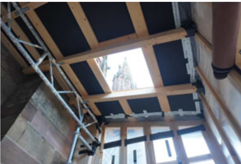
Abb. 18: Dachöffnung für das Herausheben der Eckfialen 18.12.2025 (MBV, A. Schedlbauer)
