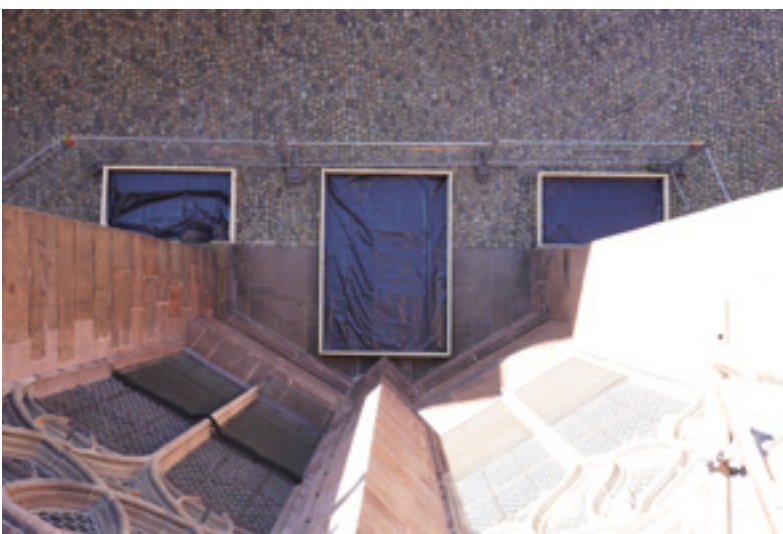
Abb. 1: Die Fundamentschalung von der Chorplattform aus betrachtet 19.03.2025 (MBV, A. Schedlbauer)
