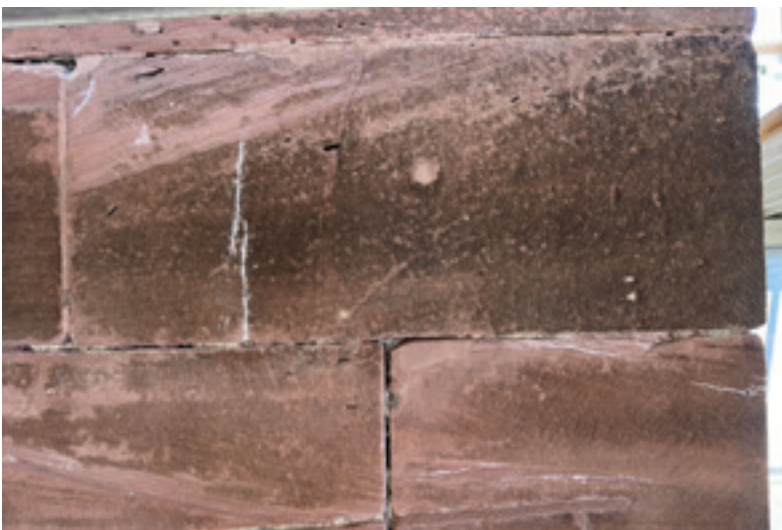
Abb. 6: zeigt die Maßnahme Rissinjektion, die weiße Masse ist gut zu erkennen. 30.05.2025 (L. Kürten)
