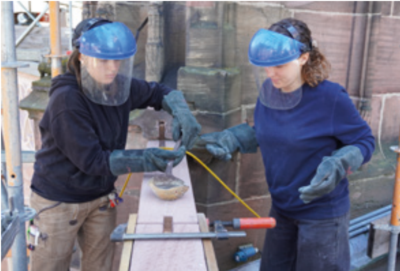
Abb. 12: Verbinden der Maßwerkteile mit Kupferklammern und Blei 14.10.2025 (MBV, A. Schedlbauer)
