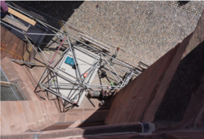
Abb. 5: Die unterste Lage der drei miteinander verbundenen, lastabtragenden Gerüsttürme 09.04.2025 (MBV, A. Schedlbauer)
