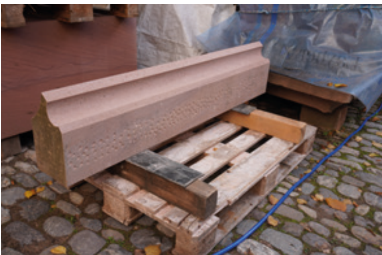
Abb. 9: Eine neugeschlagene Abdeckung ersetzt die alte rechte Maßwerkabdeckung aus Freudenstädter Plattensandstein. 09.10.2025 (MBV, A. Schedlbauer)
