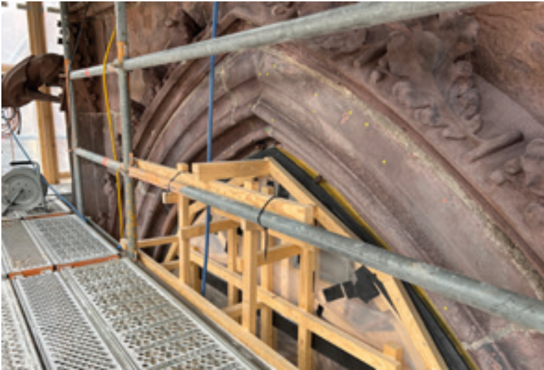
Abb. 8: Zustand nach Abnahme des Moores und anschließendem Mikrosandstrahlen. Die gelben Klebepunkte markieren rote Farbreste (vgl. Abb. 11) 15.09.2025 (J. Quatmann)
