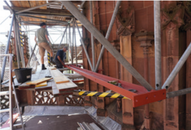
Abb. 12: Anbringen und Verbinden der Stahlteile mit dem Gerüst am Pfeiler 14.08.2025 (MBV, A. Schedlbauer)
