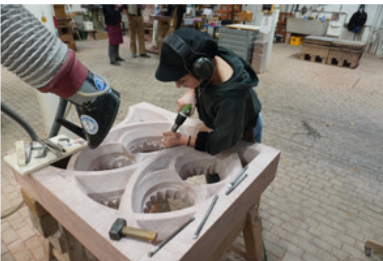
Abb. 4: Profilieren des linken Brüstungsteiles ... 17.11.2025 (MBV, A. Schedlbauer)
