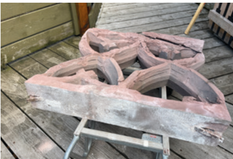
Abb. 4: Das mittlere Maßwerk nach dem Ausbau 29.07.2025 (MBV, A. Schedlbauer)
