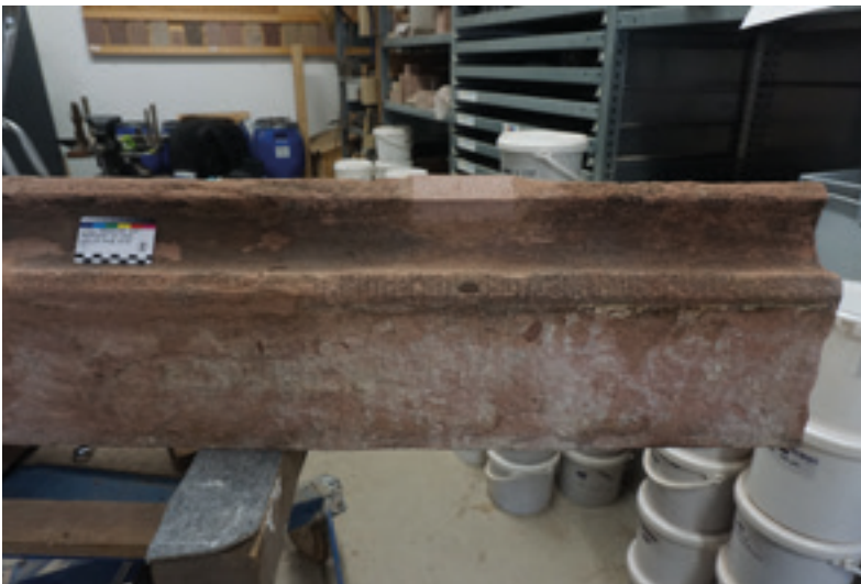
Abb. 8: Wiederherstellung der Tropfkante an der alten Abdeckung mit einer kleinteiligen Vierung 09.10.2025 (MBV, A. Schedlbauer)
