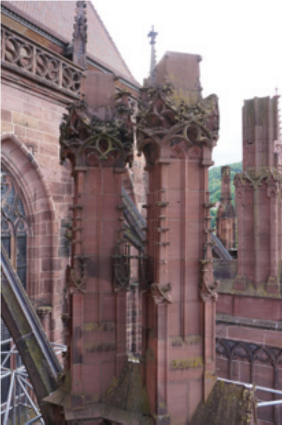
Abb. 8: Der Strebepfeiler nach Rückbau des Leichtbau- und vor dem Hochführen des Mero-Gerüstes 22.07.2025 (MBV, A. Schedlbauer)
