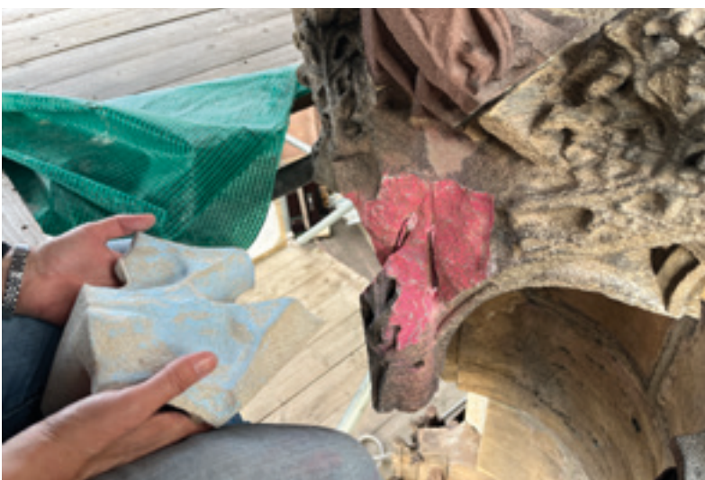
Abb. 3: Die punktierte Vierung am bauzeitlichen Baldachin beim Prozess des Anpassens. Hierbei wird die Kontaktfläche mit Kreide angemalt, um beim Ansetzen diese später erkennen zu können. 09.07.2025 (MBV, A. Schedlbauer)
