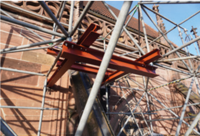
Abb. 13: Die Rückverankerung an den nach innen durchgehenden bauzeitlichen Gerüstlöchern unterhalb der oberen Hochchorgalerie 10.11.2025 (MBV, A. Schedlbauer)
