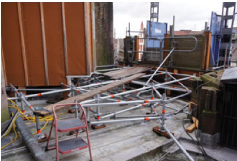
Abb. 2: Anschluss der neuen Metall-Unterkonstruktion an den Ausstieg des Gerüstaufzuges 23.10.2025 (MBV, A. Schedlbauer)
