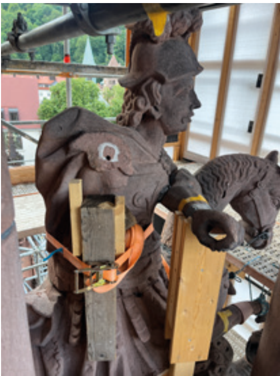
Abb. 12: Kleine Vierung in der alten Dübelbettung der Reiterfigur 22.07.2025 (MBV, A. Schedlbauer)
