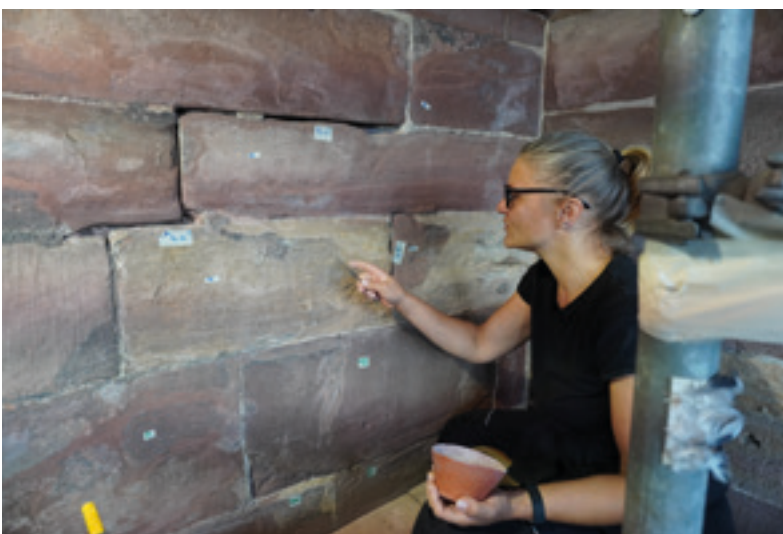
Abb. 2: Arbeiten an den bauzeitlichen Mauerquadern der Wandfläche unterhalb der Seitenschiffgalerie 30.10.2025 (MBV, A. Schedlbauer)
