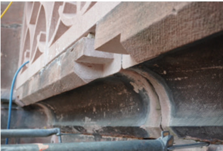
Abb. 13: Ausarbeiten der defekten Fugen der Aufstands-Profilsteine für Vierungen 16.10.2025 (MBV, A. Schedlbauer)
