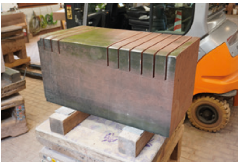
Abb. 16: Vorarbeiten mit der Brückensäge am ersten neuen Fialstück vom Pfeileraufsatz 21.08.2025 (MBV, A. Schedlbauer)
