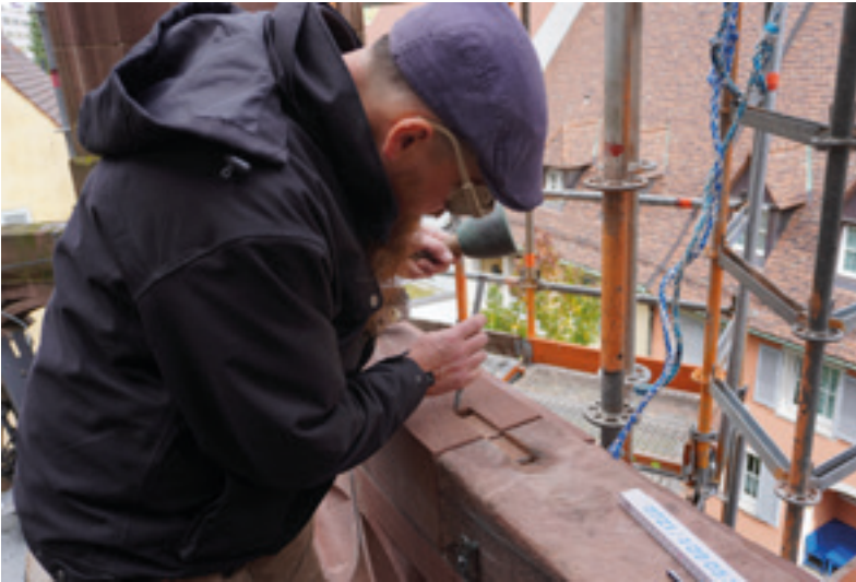
Abb. 15: Vorbereiten der fehlenden Klammertasche in der neuen Abdeckung für den Bleiverguss 23.10.2025 (MBV, A. Schedlbauer)
