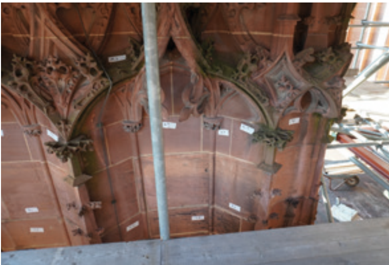
Abb. 15: Erfassung der Steinpositionen 04.12.2025 (MBV, A. Schedlbauer)
