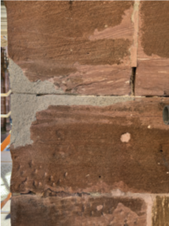
Abb. 9: zeigt den Kernaufbaumörtel in grau. 30.05.2025 (L. Kürten)
