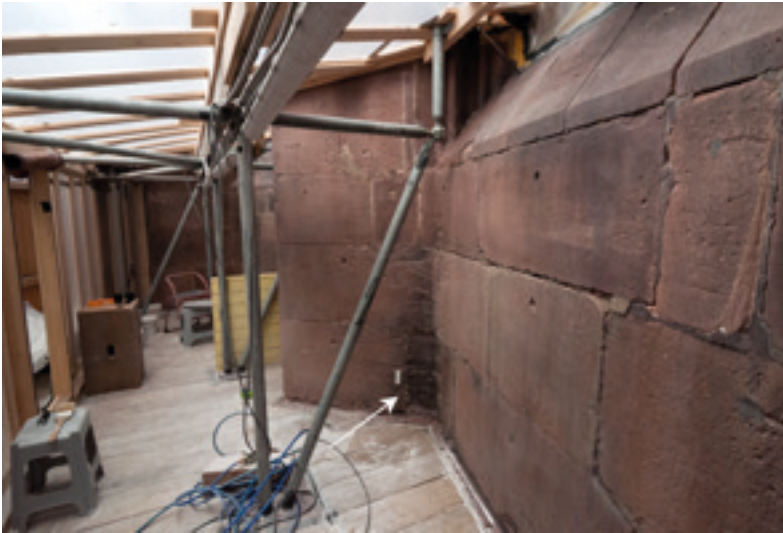
Abb. 2: Joch 14 WS1 (Schnewlin-Kapelle), Wandbereich Rechts die Wand der Schnewlin-Kapelle, mittig Flächen des Pfeilers. Der Pfeil verweist auf erhaltenen bauzeitlichen Fugenmörtel mit roten Farbresten (vgl. Abb 3). 11.12.2025 (J. Quatmann)
