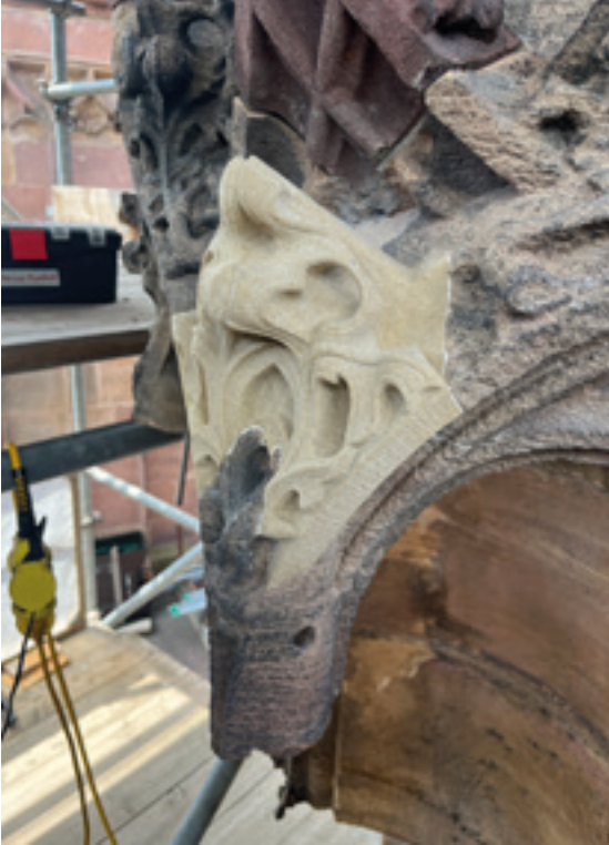
Abb. 4: Fertig angepasste und eingeklebte Vierung 29.07.2025 (MBV, A. Schedlbauer)
