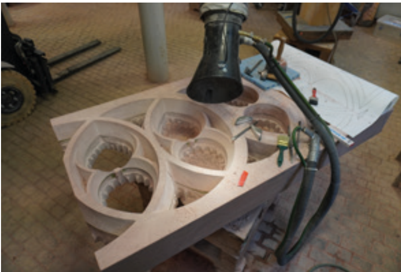
Abb. 6: ... und des rechten Werkstückes, das mit einer Schräge zum nördlichen Strebepfeiler 13/14 anschließt. 22.10.2025 (MBV, A. Schedlbauer)
