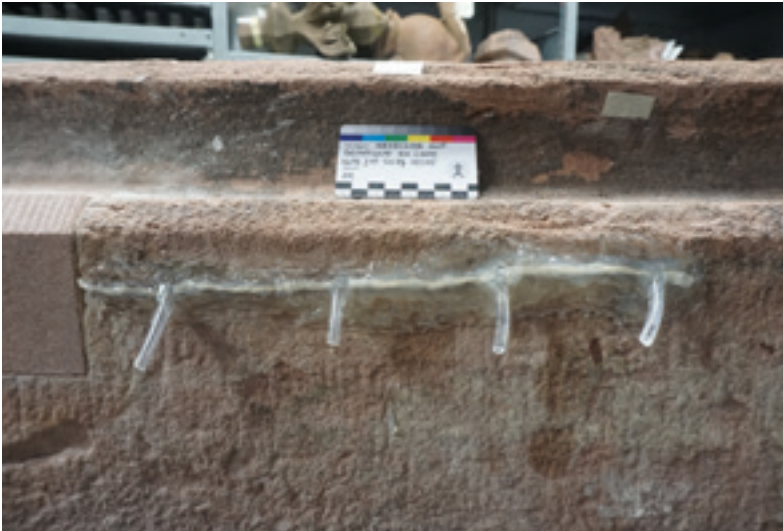
Abb. 7: Rissverfüllung an der bauzeitlichen linken Maßwerkabdeckung 01.10.2025 (MBV, A. Schedlbauer)
