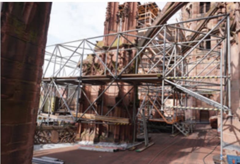
Abb. 9: Überleitung des vom Münsterplatz aufgehenden Gerüstes zur Hochchorwand Die Gitterkonstruktion ist zur Einpassung der Stahlteile vorübergehend gesichert. 29.07.2025 (MBV, A. Schedlbauer)
