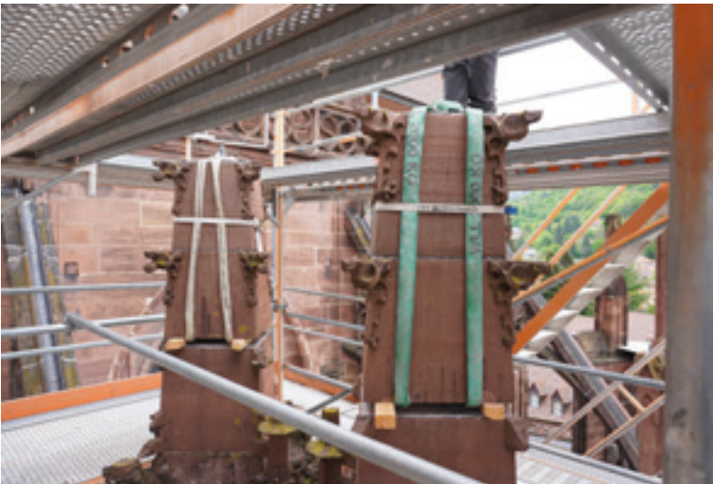
Abb. 6: Zwei weitere Steinlagen werden zur Sicherung über das noch vorhandene Untersuchungsgerüst abgenommen 23.04.2025 (MBV, A. Schedlbauer)
