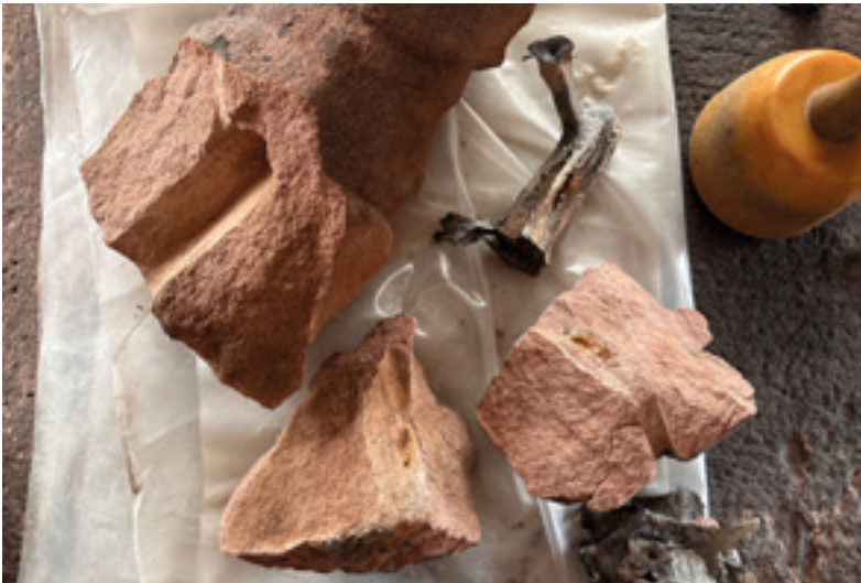
Abb. 5: zeigt den rechten Oberarm vom Heiligen Georg. Es zeigt die gleichen Schadensmechanismen wie die Abb. 4. 01.03.2025 (L. Kürten)
