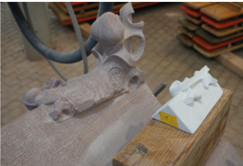
Abb. 18: Angleichen der unterschiedlichen Krabbenstängel mit Hilfe von abgenommenen Formen der Vorlagen 27.11.2025 (MBV, A. Schedlbauer)
