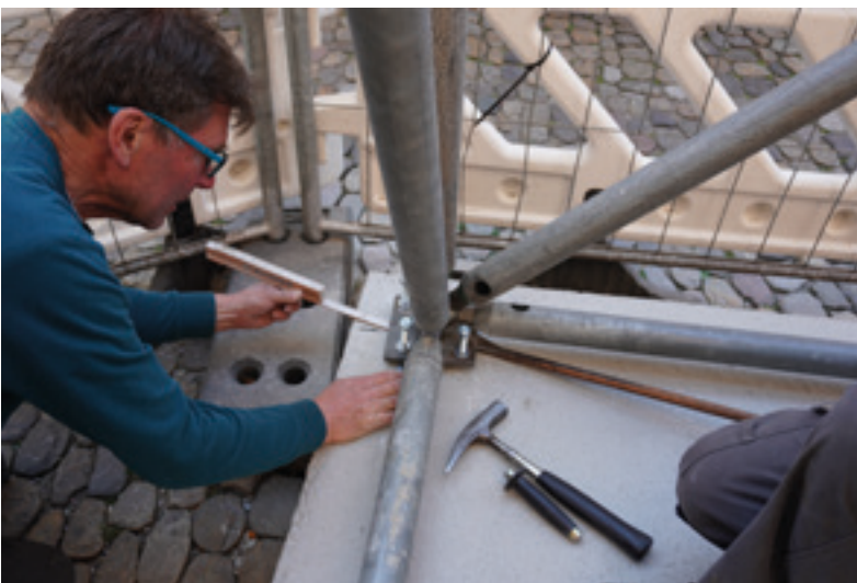
Abb. 4: Fixieren der untersten Gerüstlage mit Betonschrauben 09.04.2025 (MBV, A. Schedlbauer)
