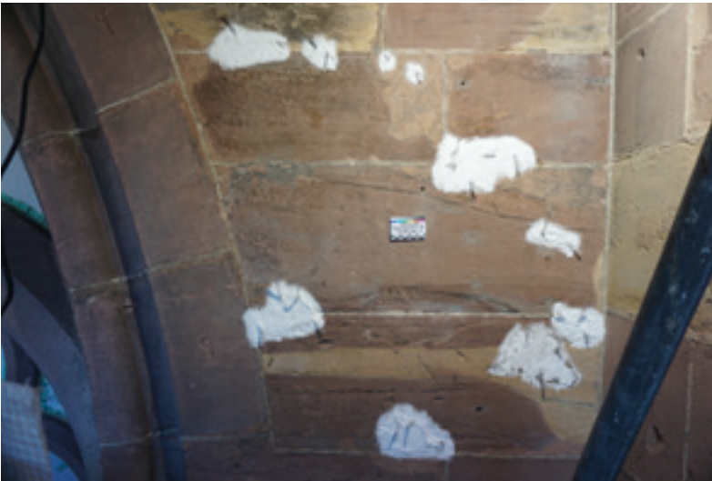
Abb. 4: ... während der Schaleninjektion ... 24.06.2025 (MBV, S. Eberhardt)
