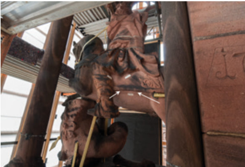
Abb. 1: Vor der Reinigung. Die Pfeiler weisen auf einen deutlichen Beleg dafür, dass die ehemals vorhandene Bemalung mit Säure oder Lauge entfernt worden ist (vgl. Abb. 2) 13.09.2024 (J. Quatmann)
