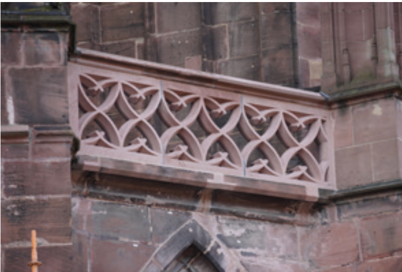
Abb. 16: Das neue Brüstungselement nach dem Rückbau des Leichtbaugerüsts 04.12.2025 (MBV, A. Schedlbauer)
