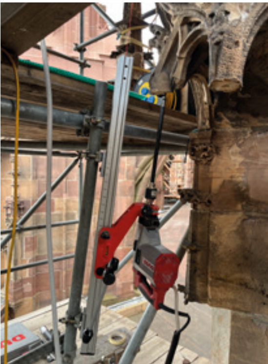
Abb. 5: Bohrlafette mit Kernbohrgerät beim Ausbohren der alten Dübel-Verbindung 08.10.2025 (MBV, A. Schedlbauer)
