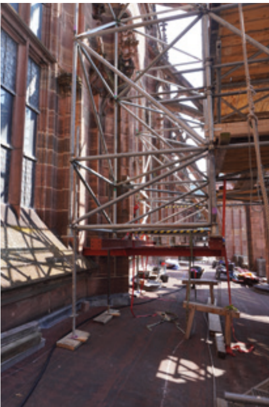
Abb. 11: Einpassen der stählernen Unterkonstruktion in die vorhandenen, bauzeitlichen Gerüstöffnungen in der Hochchorwand 12.08.2025 (MBV, A. Schedlbauer)
