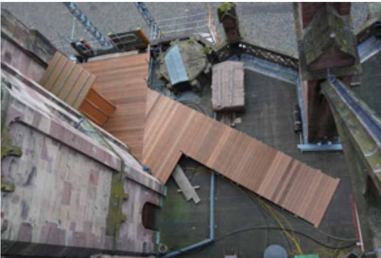
Abb. 4: Der neue Belag von oben betrachtet. Es fehlen noch die Seitengeländer und der Abschluss zur Brüstung am Aufzug. 23.12.2025 (MBV, A. Schedlbauer)
