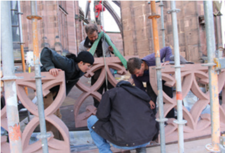
Abb. 10: Einpassen der neuen Brüstungsteile 07.10.2025 (MBV, A. Schedlbauer)
