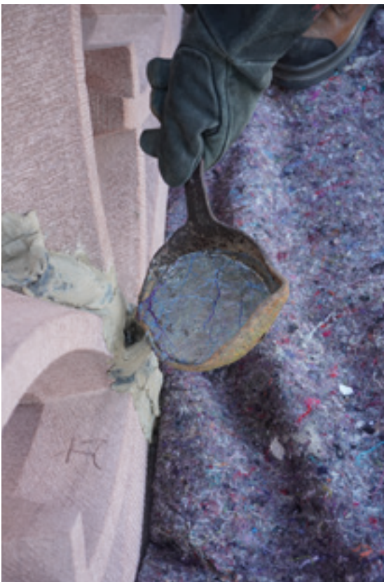
Abb. 11: Verguss der vertikalen Stoßfugen mit Blei 14.10.2025 (MBV, A. Schedlbauer)
