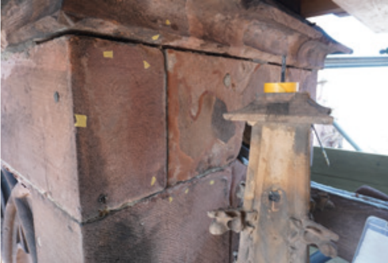
Abb. 6: Restaurierungsarbeiten an der Stirnseite des Strebepfeilers 08.10.2025 (MBV, A. Schedlbauer)
