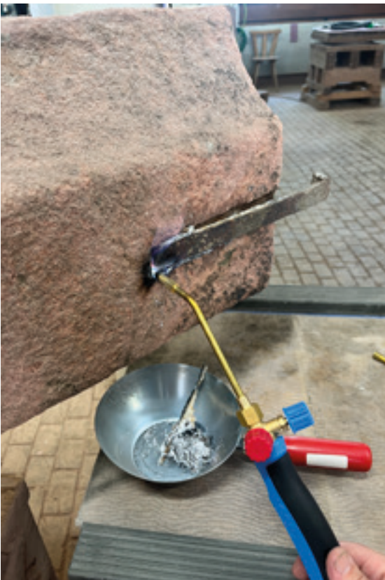
Abb. 6: Das Blei der alten Klammer wird mit einem Gasbrenner ausgeschmolzen. 13.08.2025 (MBV, A. Schedlbauer)
