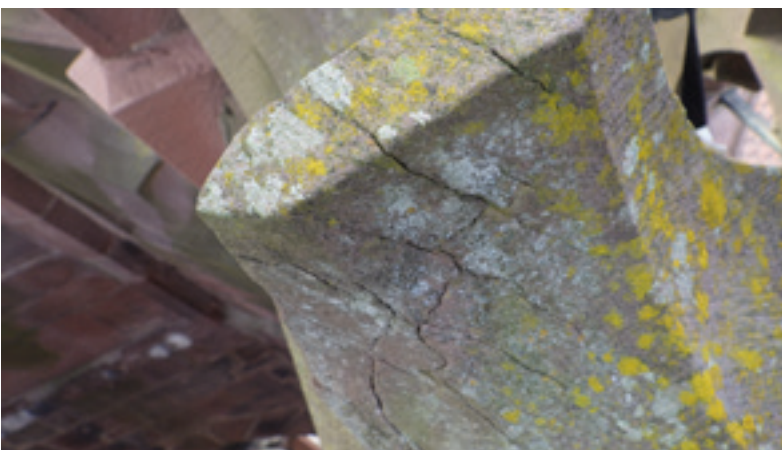
Abb. 2: Rissbildung an den Maßwerken der Pyramide des nördlichen Hahnenturms 04.07.2025 (MBV, H. Koch)
