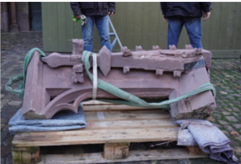
Abb. 20: Auf einer Palette fixierte Eckfiale fertig zum Abtransport mit dem Gabelstapler in die Münsterbauhütte 18.12.2025 (MBV, A. Schedlbauer)
