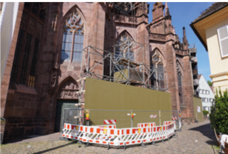
Abb. 7: Einbau der hölzernen Einstiegssicherung 28.04.2025 (MBV, A. Schedlbauer)
