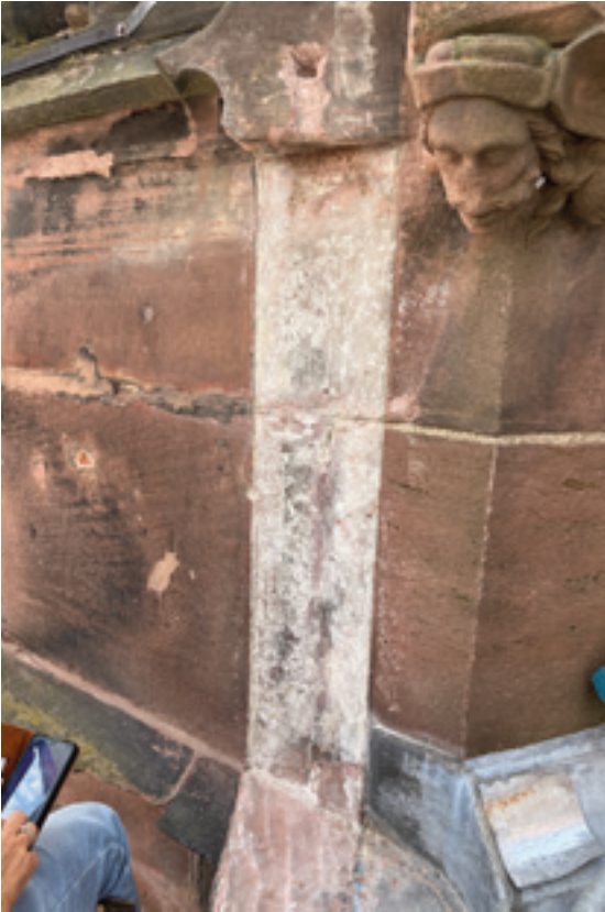
Abb. 5: Anschluss an den Strebepfeiler 15/15 05.08.2025 (MBV, A. Schedlbauer)
