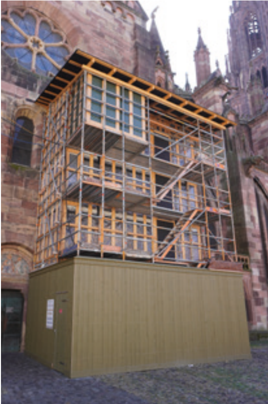
Abb. 13: Einrüstung mit Staubeinhausung zur Farbbefundung 18.08.2025 (MBV, A. Schedlbauer)
