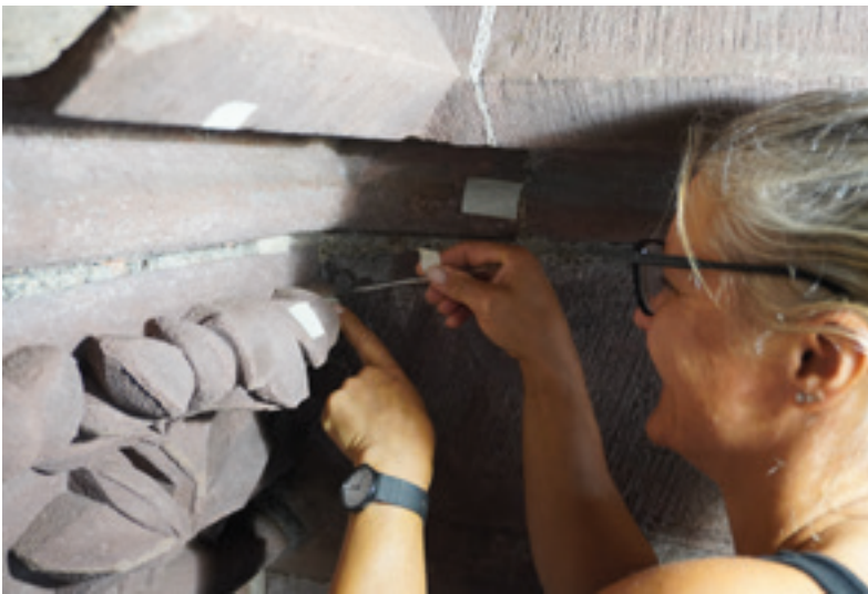
Abb. 1: Konservierung der Mürbezonen am Blattfries unterhalb der Seitenschiffgalerie 14.10.2025 (MBV, A. Schedlbauer)
