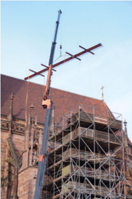
Abb. 14: Vor dem Einbau des Daches wird die Laufkranbahn am Gerüst montiert. 19.11.2025 (MBV, A. Schedlbauer)
