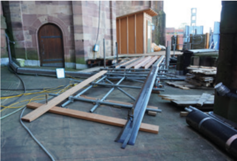
Abb. 3: Übergang der Rampe auf die schräge Chorplattform 04.12.2025 (MBV, A. Schedlbauer)
