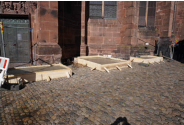
Abb. 3: Die drei gefüllten Schalungen neben dem Südlichen Choreingang 19.03.2025 (MBV, A. Schedlbauer)
