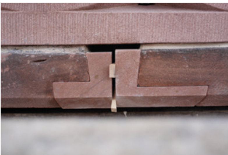
Abb. 14: Einkleben der passgenauen Vierungen mit Steinsilikatkleber 21.10.2025 (MBV, A. Schedlbauer)
