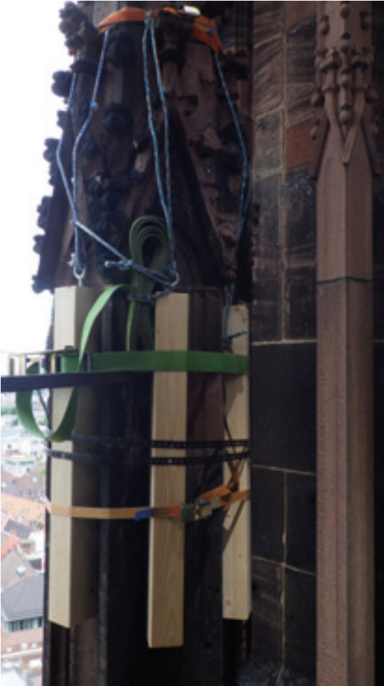
Abb. 1: Die neue Sicherungsbandage der Fiale am nordwestlichen Dreikantpfeiler 24.09.2025 (MBV, T. Borsdorf)
