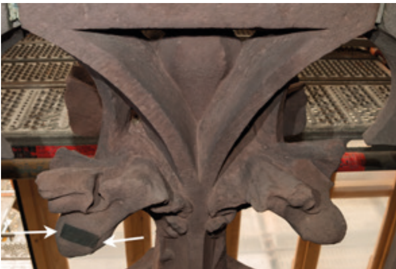
Abb. 6: Zustand nach dem Mikrosandstrahlen. Die Pfeile weisen auf die Primärstelle, die nicht gereinigt worden ist. 14.11.2025 (J. Quatmann)
