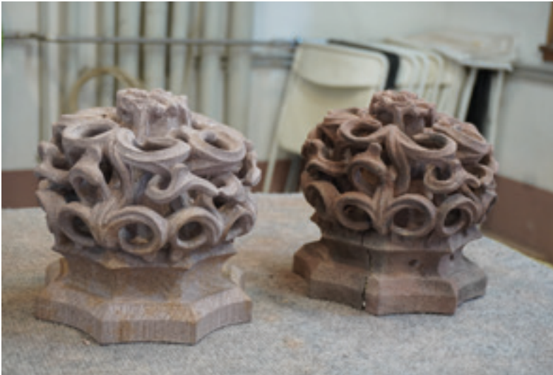
Abb. 1: Neu gefertigter Abhängling mit der Vorlage aus den 1930er Jahren 06.08.2025 (MBV, A. Schedlbauer)
