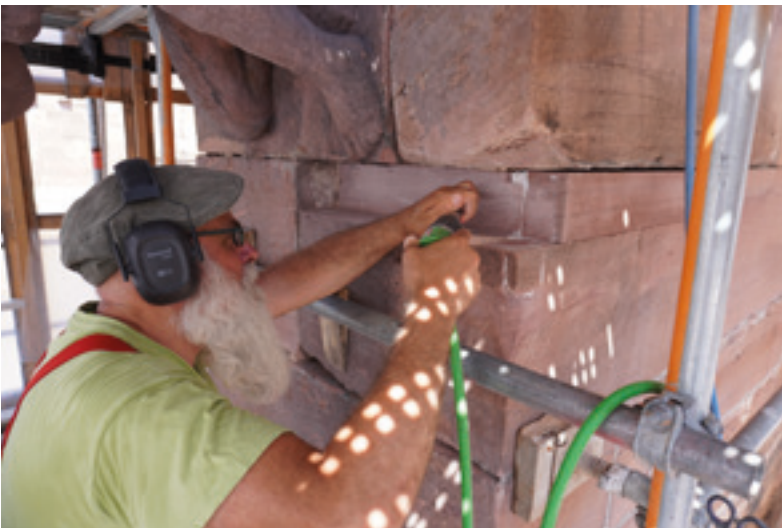
Abb. 15: Letzte Vorarbeiten vor dem Einsetzen der Vierung 01.07.2025 (MBV, A. Schedlbauer)
