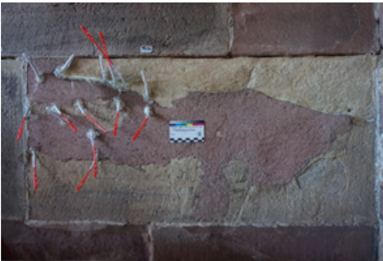
Abb. 1: Rissinjektion und Hinterfüllen von Hohlstellen an einer Antragung des sog. Meyer-Kitts 14.10.2025 (MBV, S. Eberhardt)
