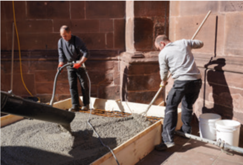
Abb. 2: Das Befüllen der Schalungen mit armiertem Beton 19.03.2025 (MBV, A. Schedlbauer)
