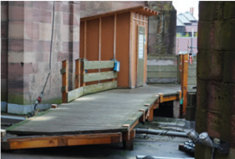
Abb. 1: Die alte Rampe von 2012 während des Rückbaus 24.09.2025 (MBV, A. Schedlbauer)
