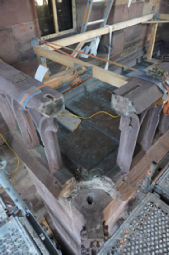
Abb. 17: Die Lücke der östlichen Ecklisene nach dem Ausbau. Ein Stützgerüst aus Metall, Holz und Spanngurten sichert die freistehenden Maßwerkbrüstungsteile. 18.12.2025 (MBV, A. Schedlbauer)
