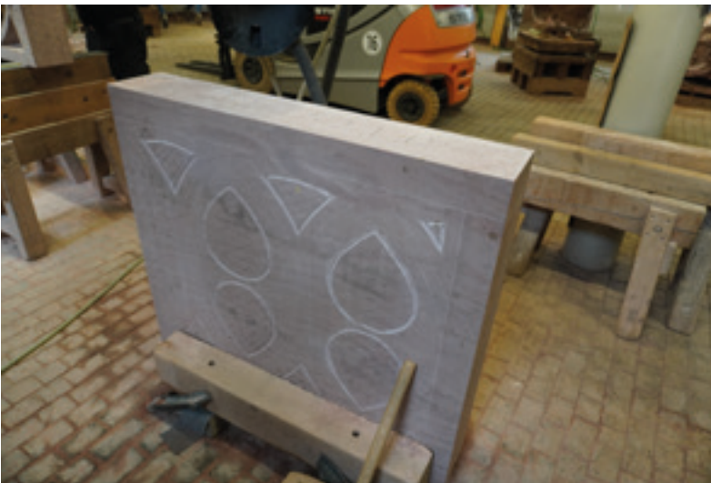
Abb. 3: Sicherung der Kanten für das Vorbohren mit dem Kernbohrgerät 28.08.2025 (MBV, A. Schedlbauer)
