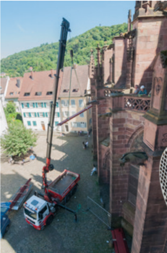
Abb. 10: Anlieferung der Stahlteile auf die nördliche Chorplattform 07.08.2025 (MBV, A. Schedlbauer)
