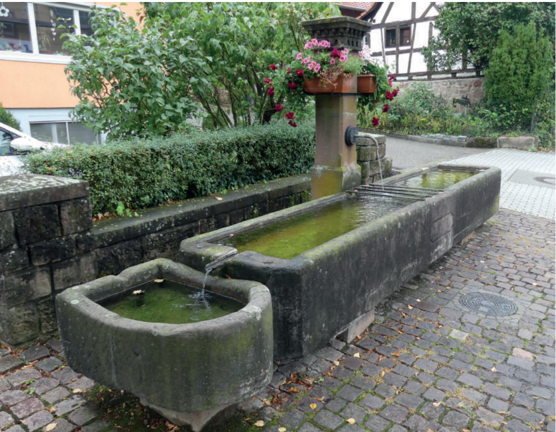
Abb. A17: Laufbrunnen an der Dreibrunnenstraße in Heimbach.
